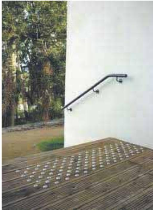
cambios de pavimento en textura y color. Igualmente será necesario para avisar de las huellas y tabicas, con cambios de pavimento o utilizando bandas adhesivas rugosas o fotoluminiscentes fácilmente detectables por usuarios con dificultades de visión.
