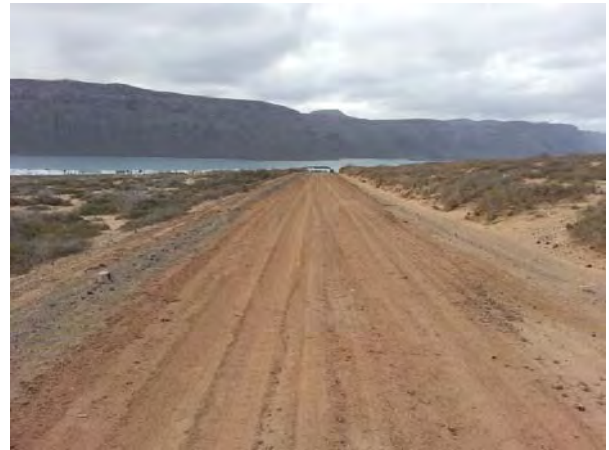
Ilustración 24.- Pista a Caleta del Sebo reparada tras los daños de la lluvia
