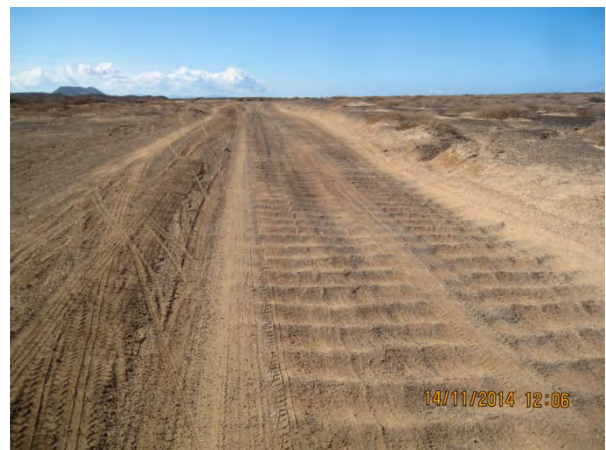
Ilustración 18.- Rizo (ondas superficiales), provocadas por un exceso en la velocidad de los vehículos
