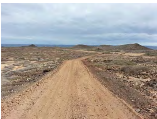
Ilustración 23.- Reparación de pistas mediante extendido de material
