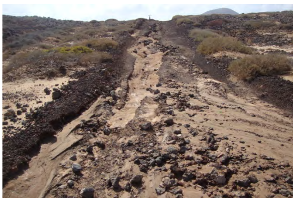
Ilustración 19.- Cárcavas producidas por la escorrentía superficial con arrastre de sólidos
