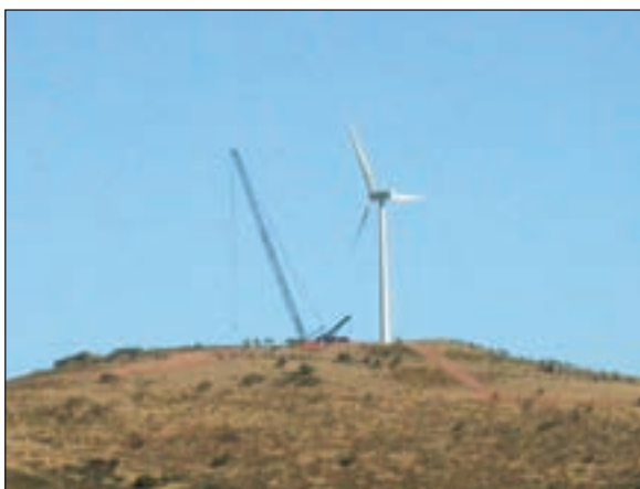
Figura 4-98. Construcción y montaje de un aerogenerador, con grúas de gran altura, en Castilla y León.
