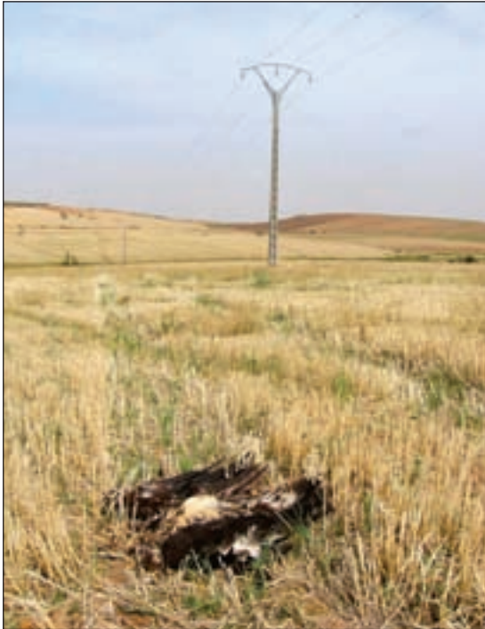
Figura 4-77. Buitre negro muerto por electrocución o por colisión con los cables de un tendido eléctrico en el este de Madrid (Carlos Ponce).
