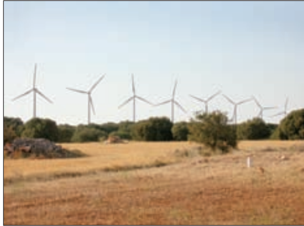
Figura 4-94. Parque eólico en área de monte mediterráneo.
