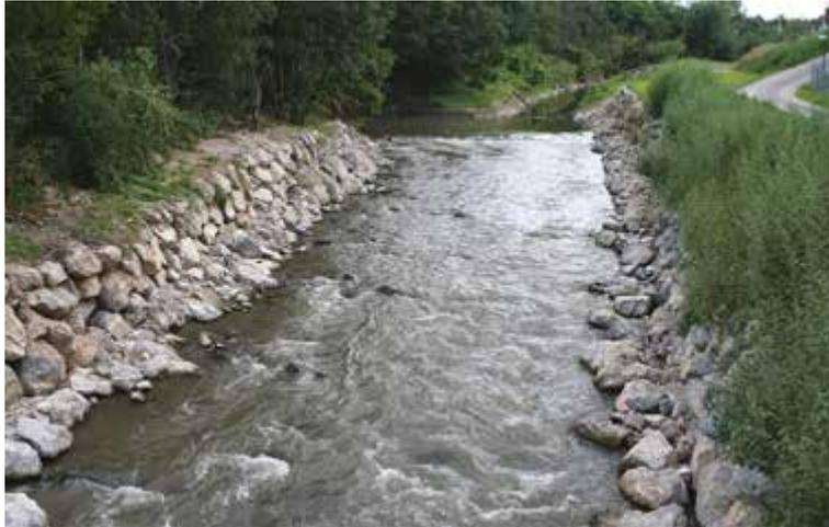
Figura 6.6. Rampa de piedras con sección cóncava.
