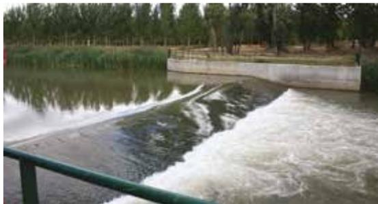
Figura 5.8. Estación de aforos del tipo V-flat, en el río Carrión.
