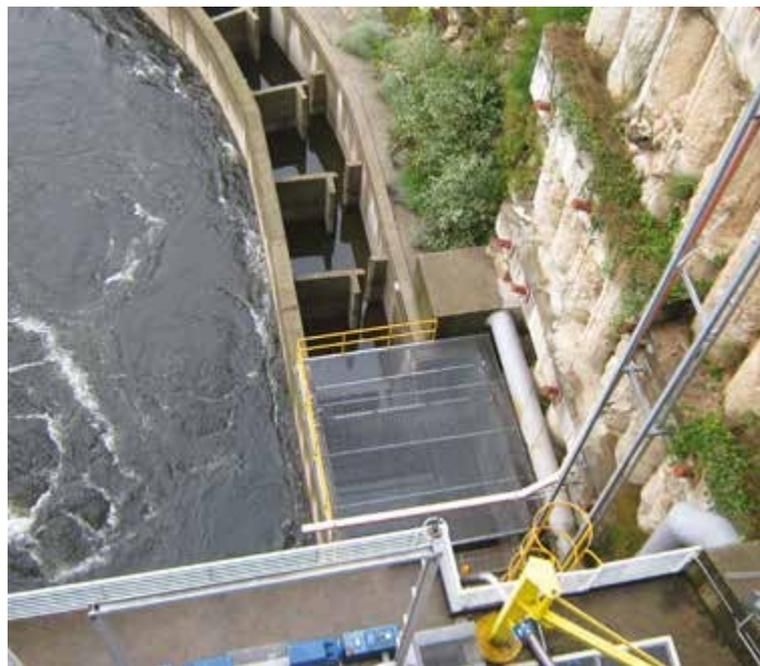
*Figura 3.3. Escala de hendiduras terminado en un capturadero de peces.*
