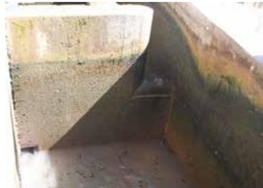
*Figura 4.12. En la parte superior una escala de artesas sucesivas. En la parte inferior, escala de artesas sucesivas de la presa de Mugo, río Duero. Detalle del vertedero lateral y del orificio de fondo de la artesa.*
