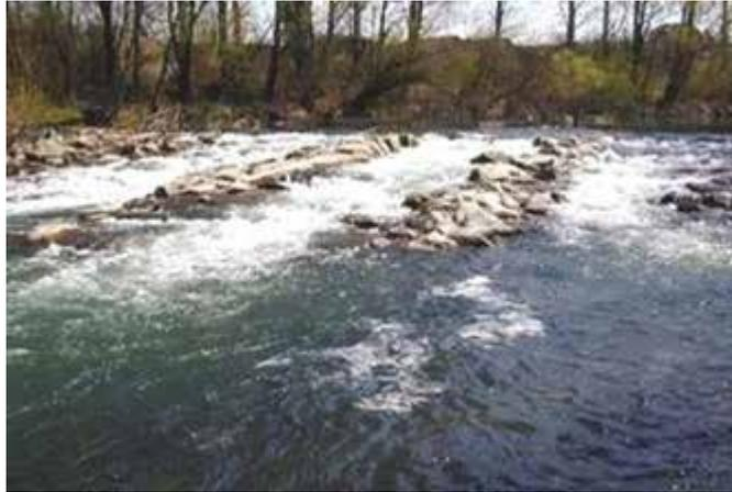
*Figura 6.9. Rampa de piedras con sección dividida en tres secciones cóncavas.*
