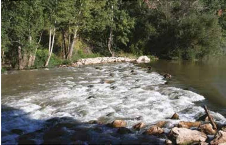
Figura 6.5. Rampa de escollera con sección cóncava en Alar del Rey (Palencia).
