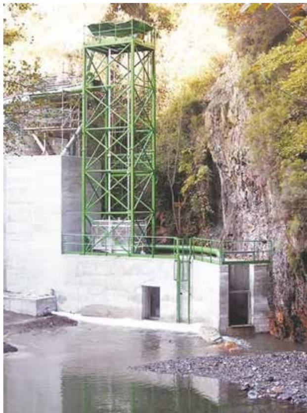
*Figura 9.14. Ascensor del azud de Olid del río Teverga en la C. A. de Asturias (original de EDP España y Proyecto).*
