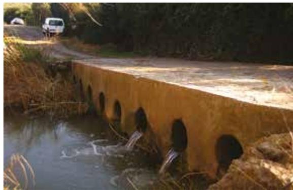
Figura 11.3. Drenaje con barrera de salto de agua.
