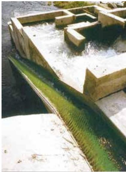
Figura 8.5. Escala de anguilas con escala convencional (Original de "Fish-pass")
