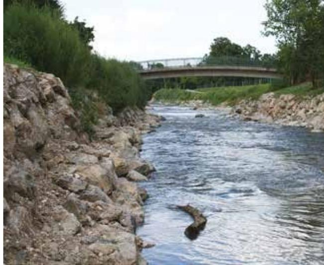
Figura 6.8. Rampa con Sección asimétrica, margen izquierda con menor velocidad.
