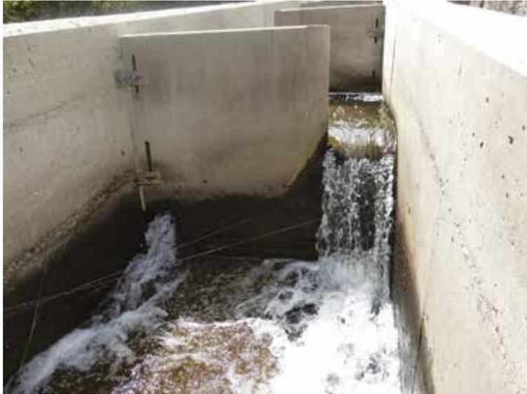
*Figura 10.11. Desnivel excesivo porque el vertedero del estanque superior y el orificio sumergido están parcialmente obstruidos.*
