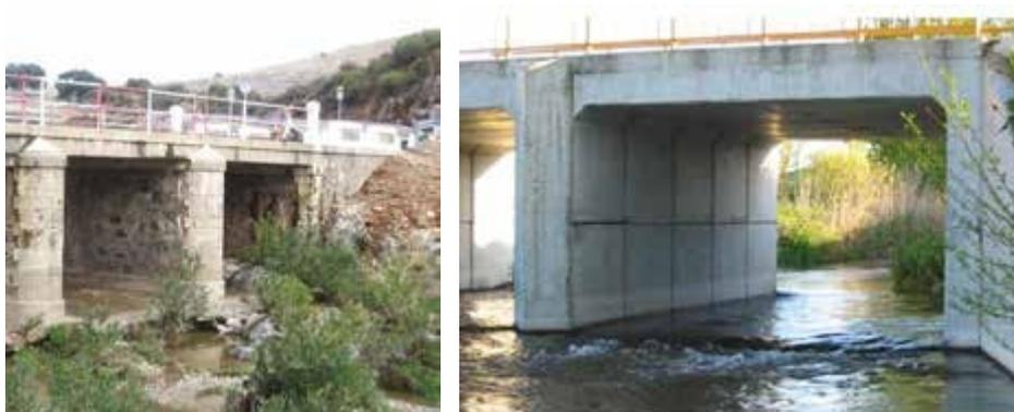
Figura 11.1, Barreras originadas por el salto de agua producido por la solera de un puente.
