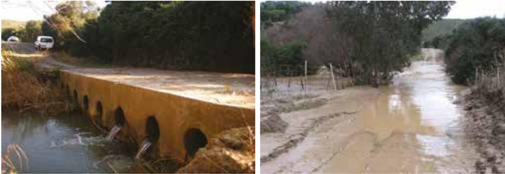
A. Drenaje. En la foto de la derecha el drenaje se encuentra con un caudal medio. En la foto de la izquierda con un caudal de crecida que anega totalmente el drenaje.
