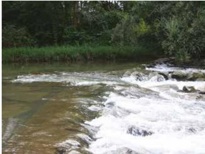
*Figura 6.10. Vista de rampa de tres secciones. Obsérvese que al no sobresalir las piedras de los umbrales se consigue un gran valor estético.*
