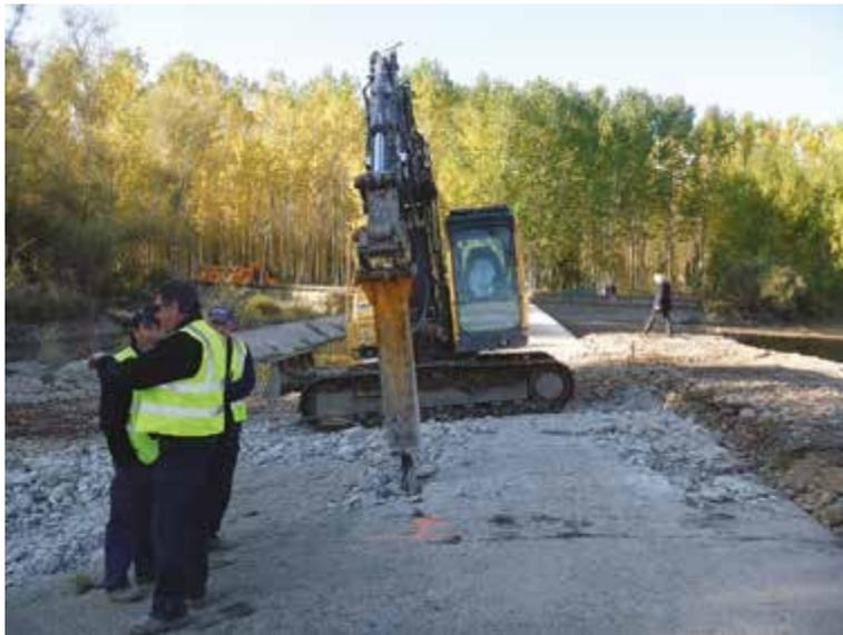
*Figura 3.2. Demolición parcial en un azud del río Órbigo (León).*
