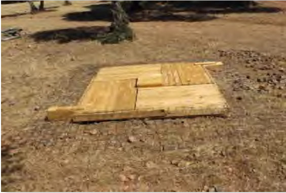
Construcción de vivares para conejo P. N. de Cabañeros.
