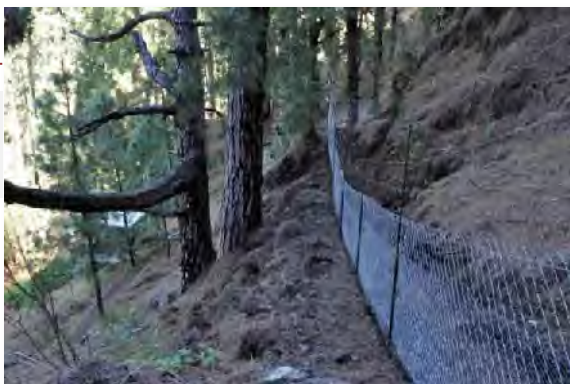
Vallado de protección pie de risco del Roque de la Brevera Macha.
