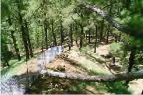
Construcción vallado pie de risco Roque de La Viña.
