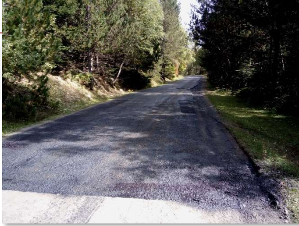
Asfaltado de la pista forestal de acceso a Sant Maurici
