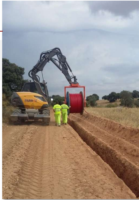
Soterramiento de línea eléctrica en la Dehesa Quinto de la Torre
