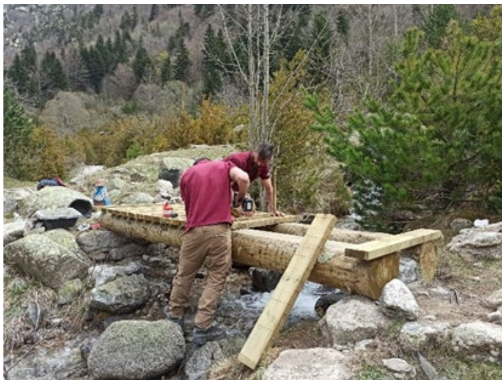
Imatge 1. Construcció del nou pont de fusta de Toirigo
