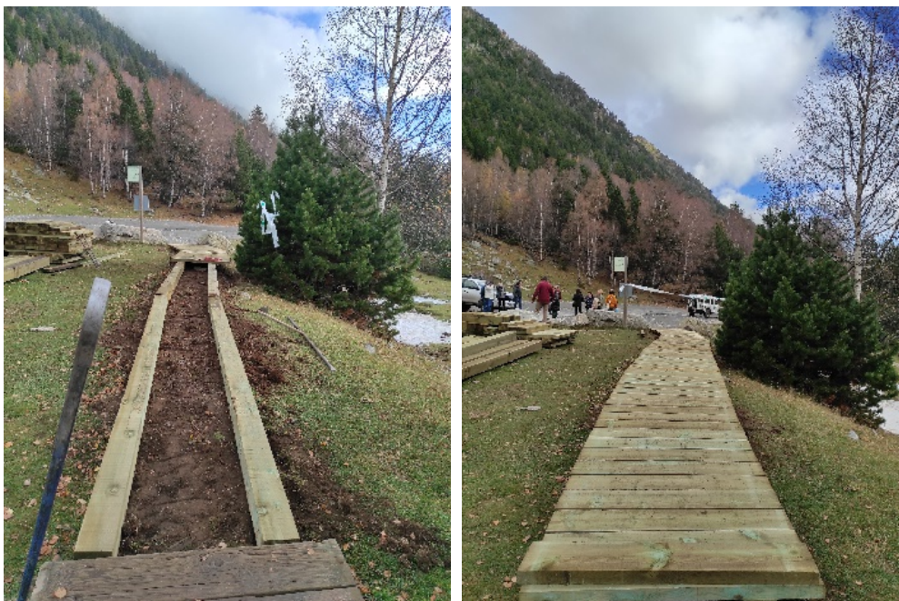
Imatge 2. Substitució del pont dels Boigots
