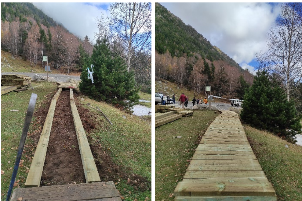
Imagen 2. Sustitución del puente dels Boigots
