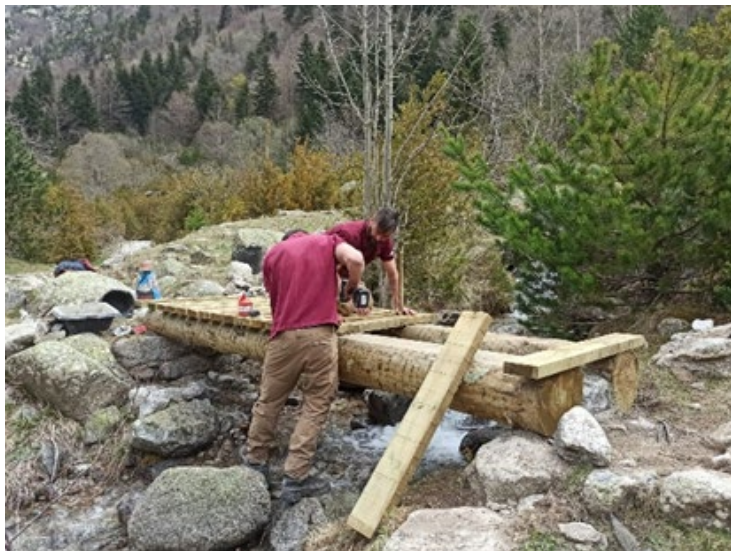
Imagen 1. Construcción del nuevo puente de madera en Toirigo.
