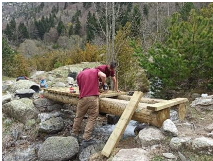
Figura 20. Construcció del nou pont de fusta de Toirigo
