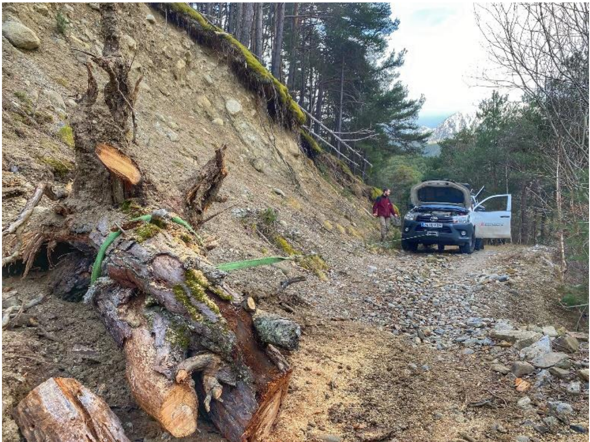
Figura 35. Retirada d'un arbre caigut en una pista forestal.
