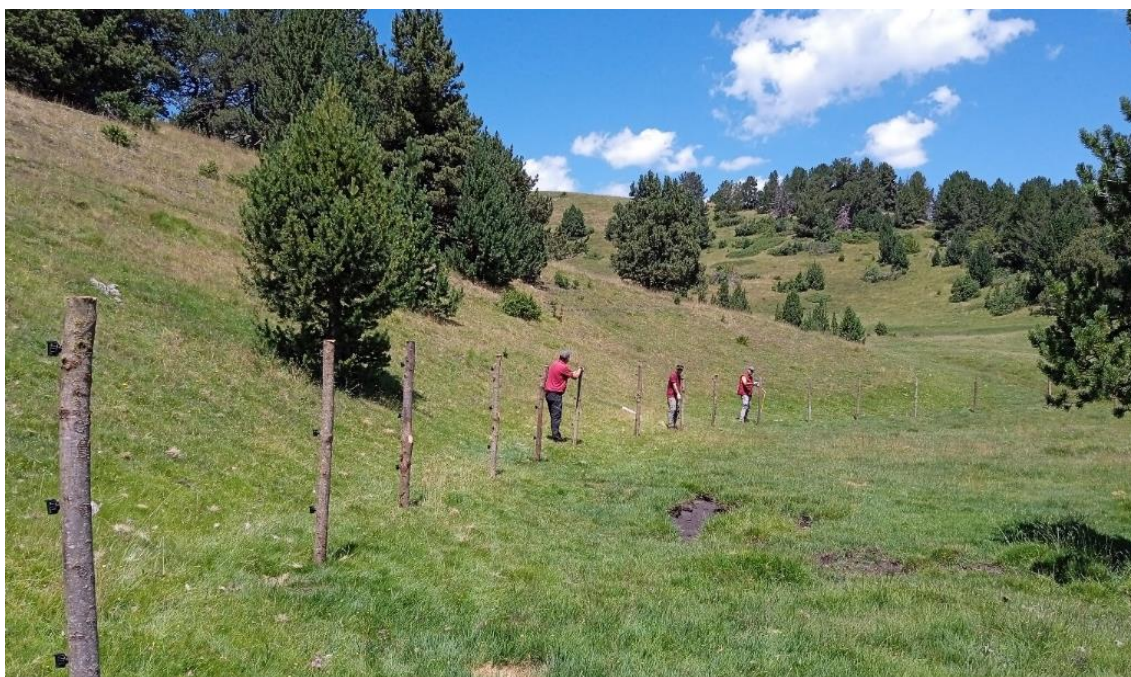
Figura 6. Instal·lació d'una tanca d'exclusió del bestiar.
