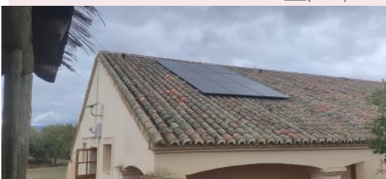
Placas solares en Palillos / P. Sánchez 📷(PNC)
