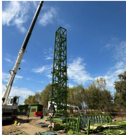
Construcción de las nuevas torres/ 📷 S. Simón (PNC)
