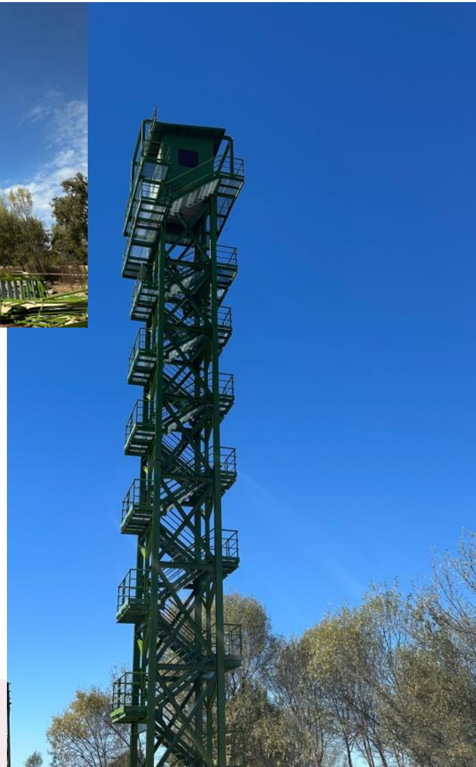
Torre de vigilancia terminada / M. García 📷(PNC)
