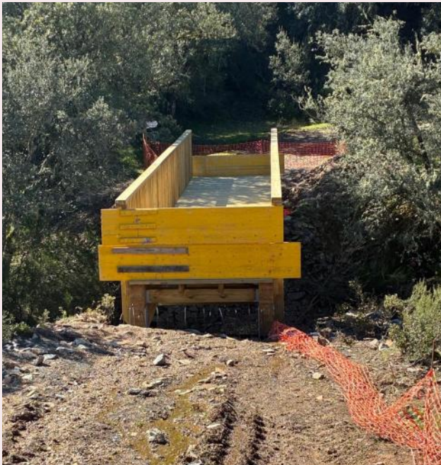
Puente sobre el arroyo del Chorríto/ 📷 P. Pozo (PNC)
