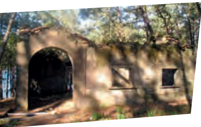
Este cuartel anexiona antiguas cuadras y posiblemente un molino por la presencia de dos piedras de molienda
