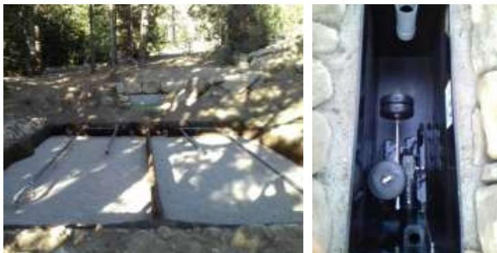
*Foto 6: Cámara sifón y sistema de drenaje con diferentes granulometrías y dos celdas alternantes.
