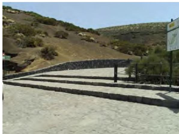
También se ha procedido a la adecuación y reordenación de la zona de Miradores de Los Roques de García. Concretamente, en el área de La Ruleta, sobre la que parten 3 senderos distintos se ha procedido a la reparación de los muretes perimetrales mediante la reposición de piezas caídas o dañadas. Asimismo se ha instalado barandilla de seguridad sobre la coronación de algunos muros, en acero corten y doble pletina de reducidas dimensiones para minimizar el
