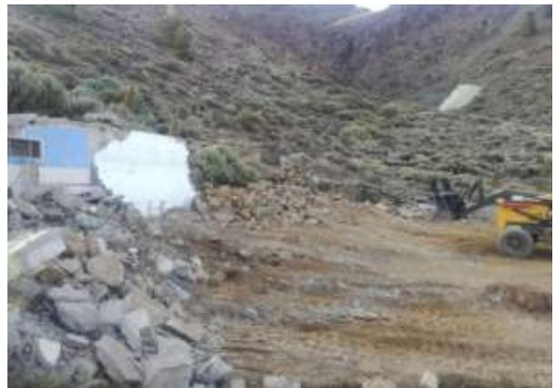
La necesidad de encauzar las aguas procedentes de la escorrentía de las laderas con los nuevos perfiles de terreno obligó a ejecutar una barranquera capaz de dirigir y evacuar la escorrentía y sus ramales derivados hacia el barranco continuo a la zona de las obras, donde se adaptó una unión con escollera de piedra de lugar para permitir el paso de las aguas por la alcantarilla que atraviesa la carretera, salvaguardando de esta forma la vía.
