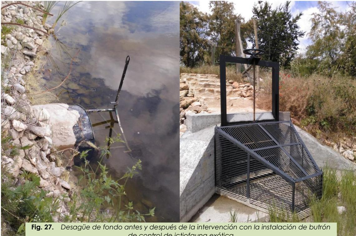
**Fig. 27.** Desagüe de fondo antes y después de la intervención con la instalación de butrón de control de ictiofauna exótica
