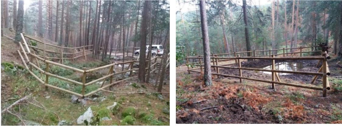
**Fig. 11.** *Excavación y cerramiento mediante talanquera*
