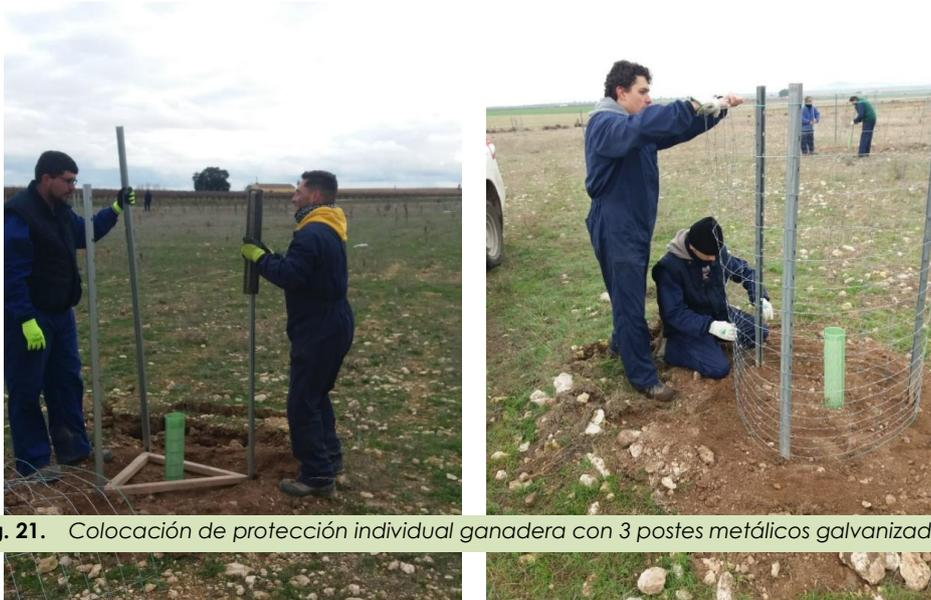
**Fig. 21.** Colocación de protección individual ganadera con 3 postes metálicos galvanizados
