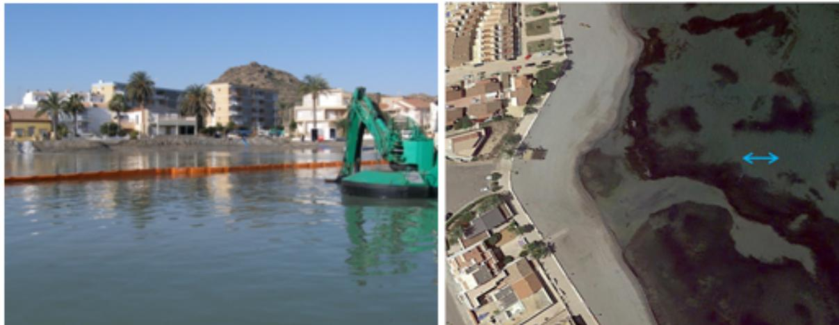
Figura 4.13: Imagen de la “araña finlandesa” o watermaster actuando en la playa de Los Urrutias en febrero de 2018 (izquierda) y foto aérea indicando la ubicación de la zona de actuación en la que estaba presente una densa pradera de *Cymodocea nodosa* (línea azul). Se aprecia claramente la acumulación de arena a la que corresponde el seco y la colonización por vegetación betónica a ambos lados del mismo. Fuente: IEO y Google Maps.
