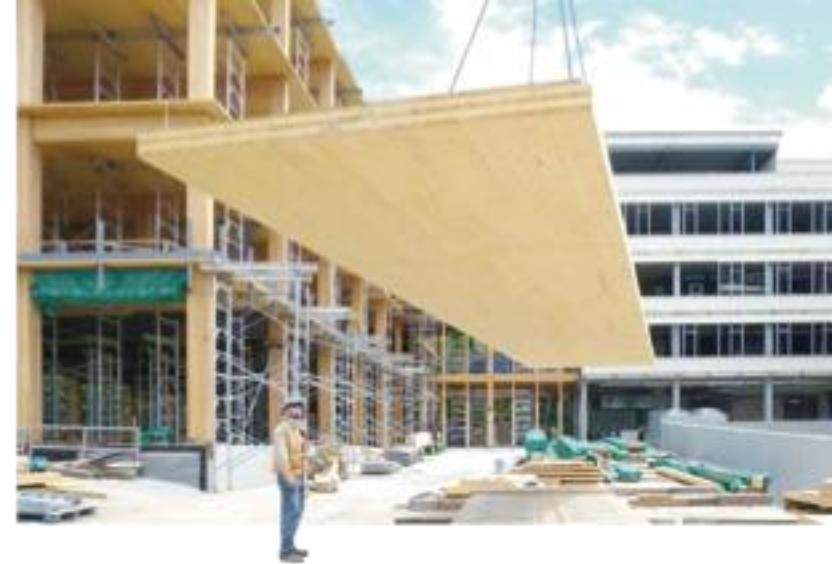
En Europa, el CLT (*cross laminated timber* o madera contralaminada estructural) compite exitosamente con materialidades estructurales como el acero, el hormigón o el ladrillo en segmentos particulares del mercado como son los edificios residenciales de media densidad.
