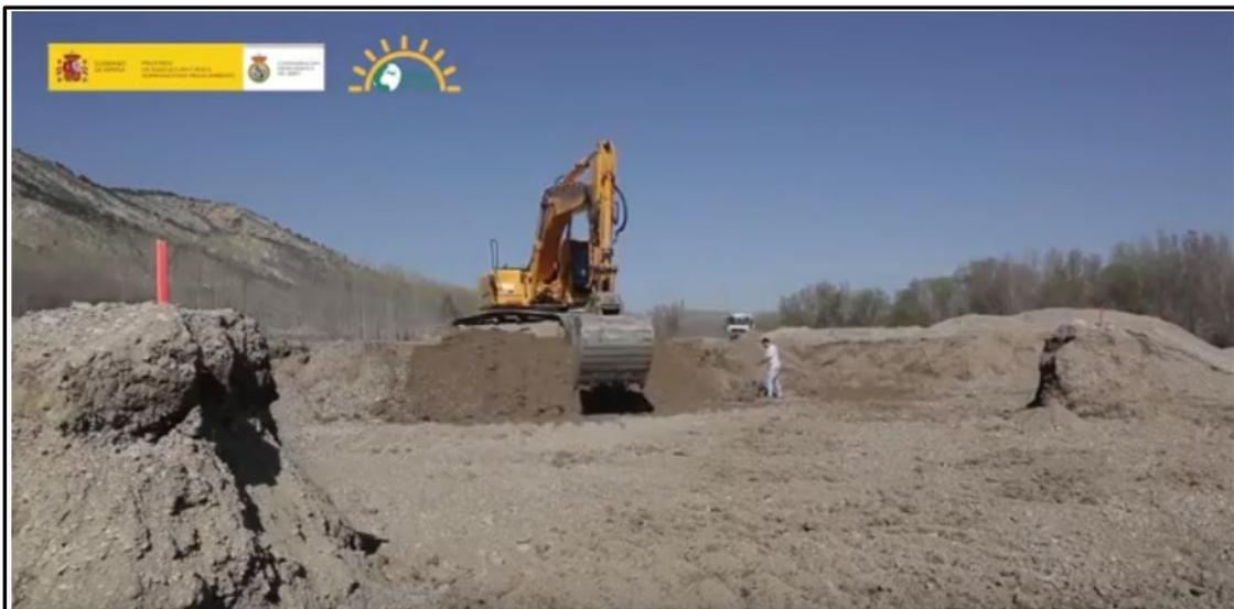
*Imagen 21. Retirada de tierra para recuperación de la llanura de inundación.*
