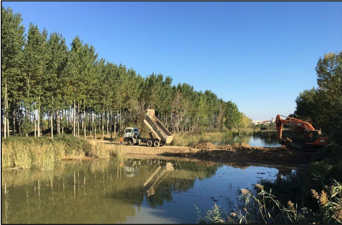
*Imagen 24. Retirada de lodos para la recuperación del lecho de gravas y arenas del antiguo meandro.*
