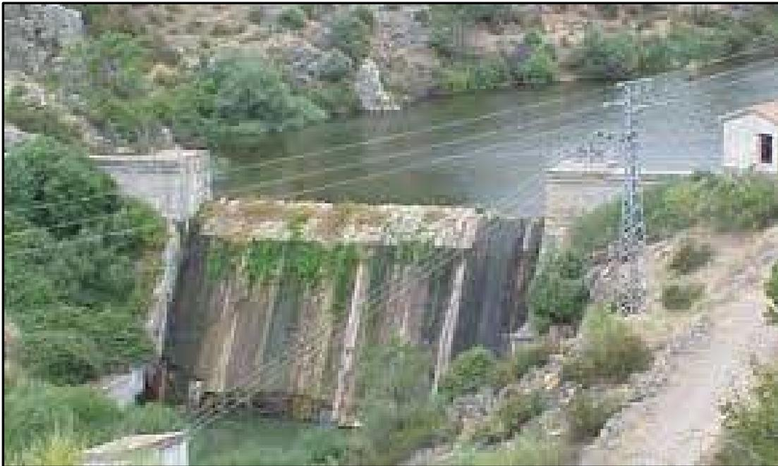
*Imagen 26. Presa de robledo de 22 m. de altura y 83 m. de coronación.*
