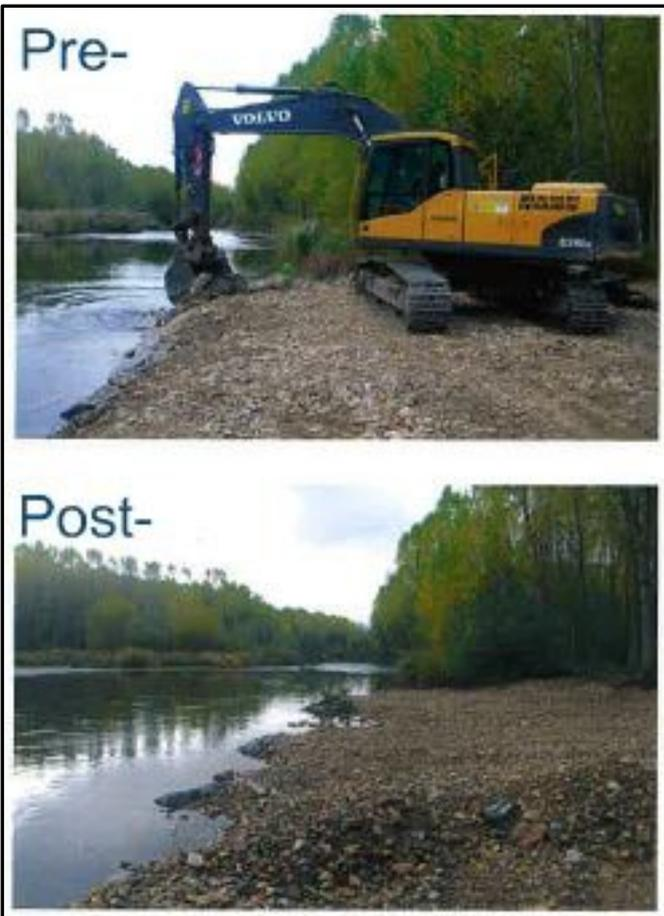
*Imagen 14. Situación antes y después de ejecución del proyecto (reperfilado de taludes).*
