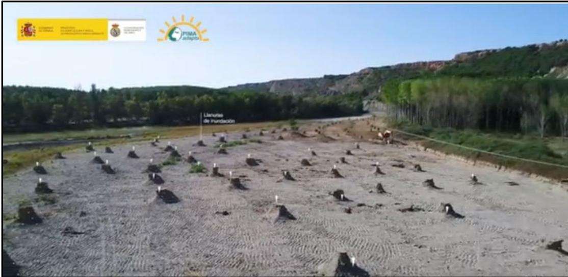
*Imagen 22. Llanura de inundación con testigos de la altura de tierra retirada.*
