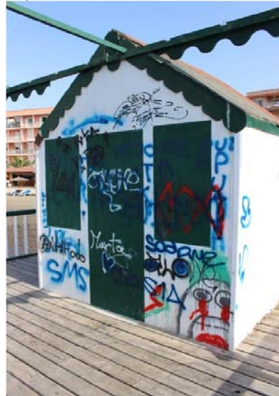
Grafitis generalizados en fachada de la caseta: Distorsión de la puerta de acceso
