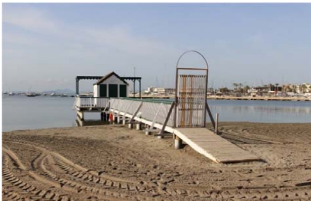
Vista general del balneario.
