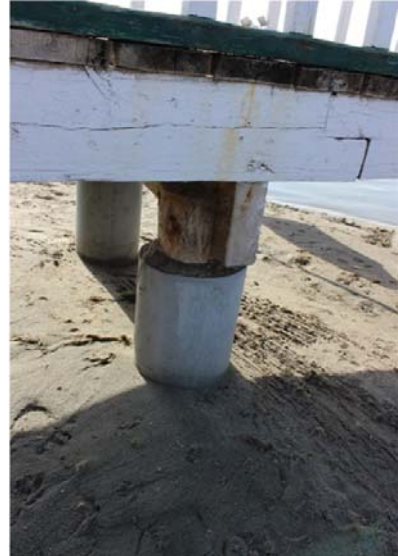
Agrietamiento en la fibra neutra
