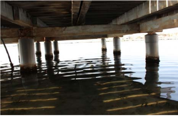
Buen estado general de los pilotes, correas y durmientes
