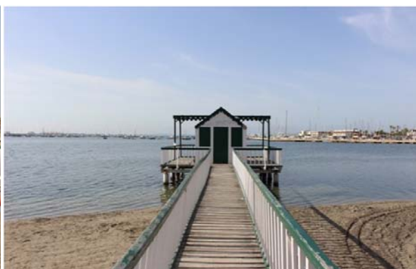
Pasarela de acceso, plataforma y caseta.
