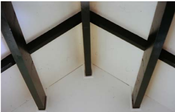
Correas y acabados en el interior de la caseta
