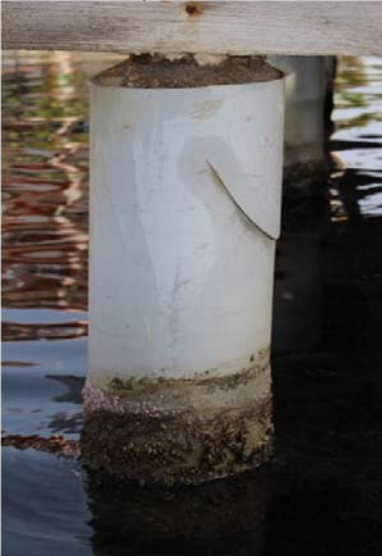
Rotura del encamisado de pvc del pilote
