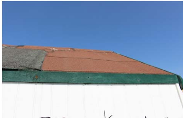
Deterioro de la lámina impermeable y su base
