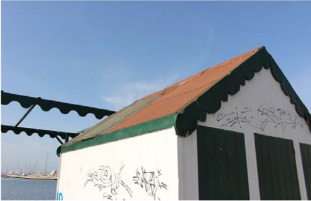
Daños en los faldones de la cubierta
