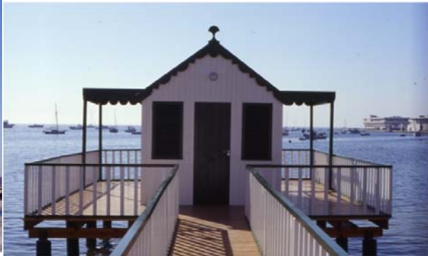
Pasarela de acceso y caseta, con las piezas de alero y tímpano
