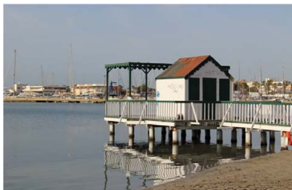
Vista general de la plataforma y caseta
