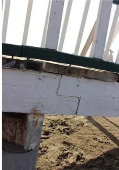
Separación de la barandilla en zona inferior
