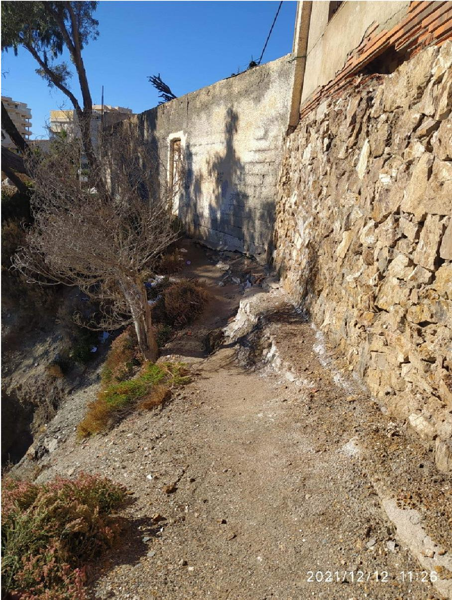
*Fotografía 17. Detalle de muro a demoler, vista hacia el sur. Fachada este del muro*
