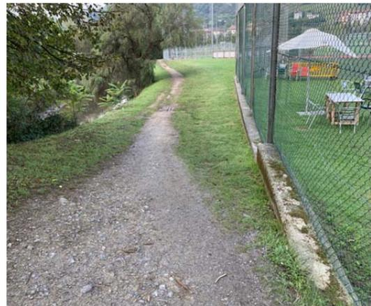
\* En las fotografías de observa el itinerario, de anchura aproximada dos metros, que bordea actualmente, en ambos márgenes del meando cercano al cauce principal de la Ría. La foto de la derecha muestra la plataforma actual en zahorra, donde se proyecta continuar con el pavimento existente (instantánea de la izquierda) a base de un tratamiento de hormigón “lavado” de fácil integración medio ambiental.
