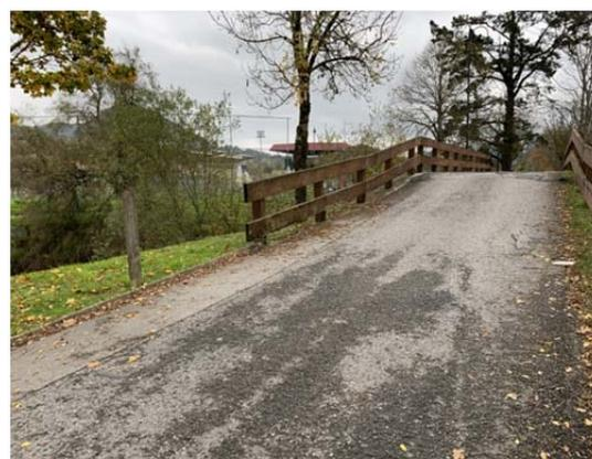
\* En la fotografía de la izquierda se observa el deterioro del entablonado que constituye la rodadura sobre la pasarela. En la instantánea de la derecha se vislumbra el acuerdo convexo, muy estricto, que ha motivado el desconchado del aglomerado por el roce con vehículos. Se efectuará un suavizado, del acuerdo en alzado, con mezcla bituminosa extendida y compactada en obra.
