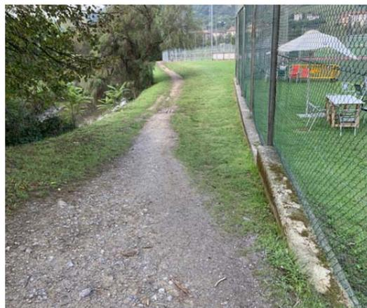
\* En las fotografías se observa el itinerario, de anchura aproximada dos metros, que bordea actualmente, en ambos márgenes del meandro cercano al cauce principal de la Ría. La foto de la derecha muestra la plataforma actual en zahorra, donde se proyecta continuar con el pavimento existente (instantánea de la izquierda) a base de un tratamiento de hormigón “lavado” de fácil integración medio ambiental.
