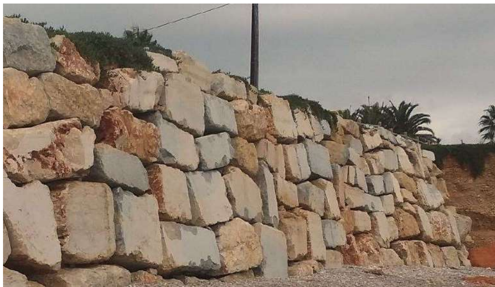
Figura 5: Muro escollera. Elaboración propia. [Oct-2022]
