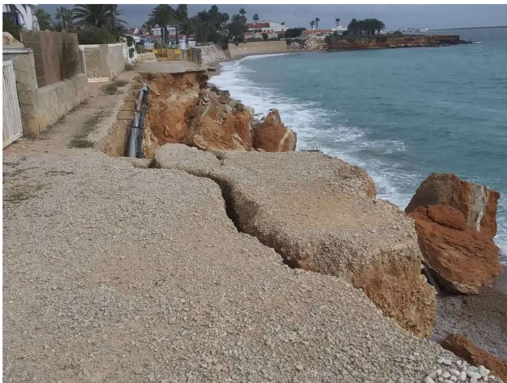
Figura 6: Zona de actuación. Vista superior 1 desde Sur. Elaboración propia. [Oct-2022]
