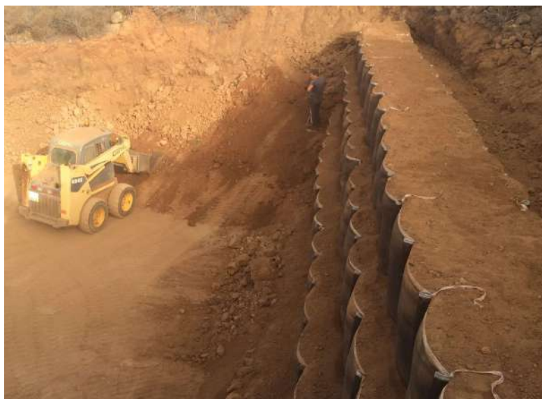
Figura 5: Construcción muro con gabión geotextil . Vista superior. Fuente: Contflexdique. [Consulta: Oct-2022]
