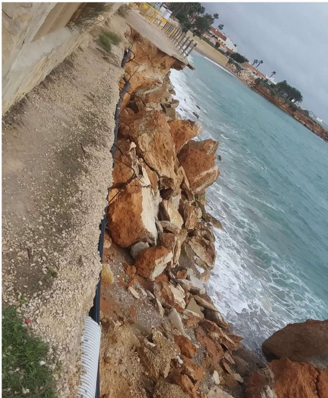
Figura 3: Zona de actuación. Vista superior 3. desde Sur. Elaboración propia. [Oct-2022]
