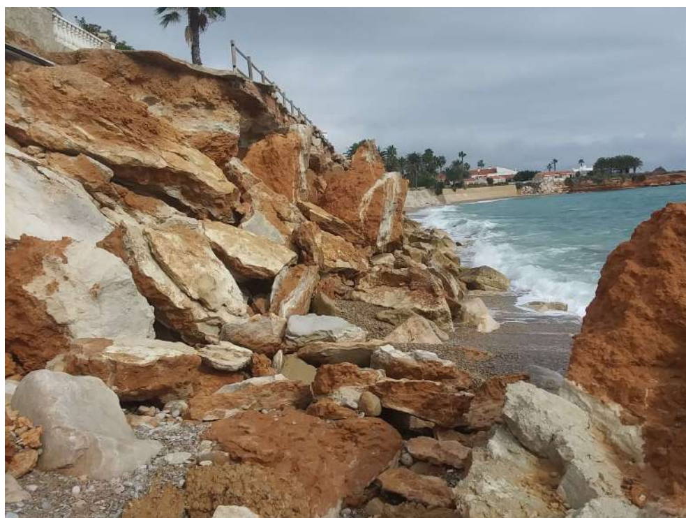
Figura 5: Zona de actuación. Vista de un lateral. Elaboración propia. [Oct-2022]
