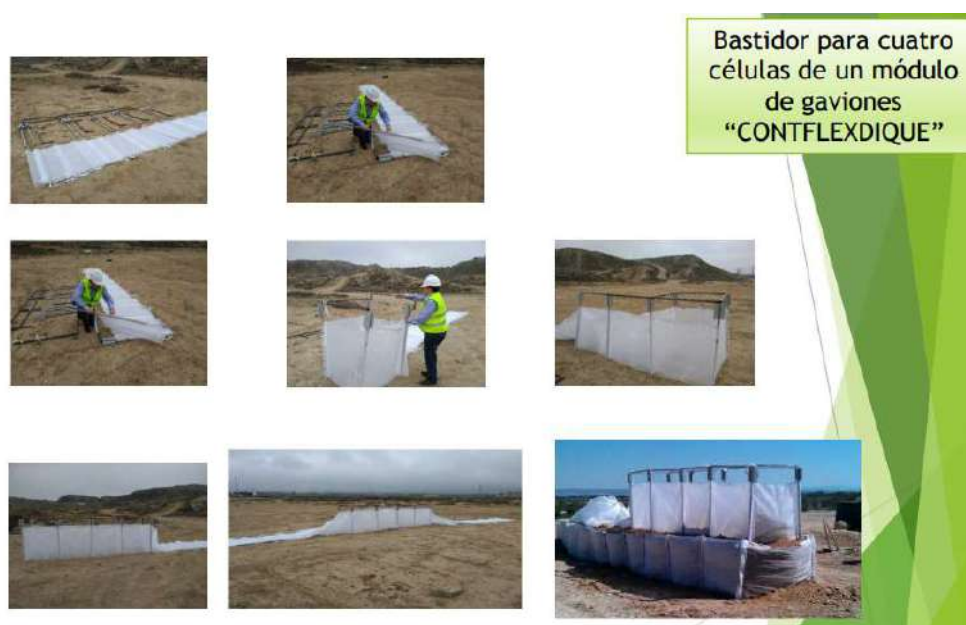
Figura 3: Fases colocación. Fuente: Contflexdiqye.[Consulta: Oct-2022]
