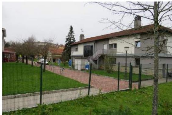
Figuras nº8 y nº9. Vial interior del antiguo hospital.
