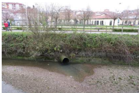
Figura nº10. Vista transversal de la calle Dolores Salis. Figura nº11. Punto de vertido existente en el canal de Dunboa.
