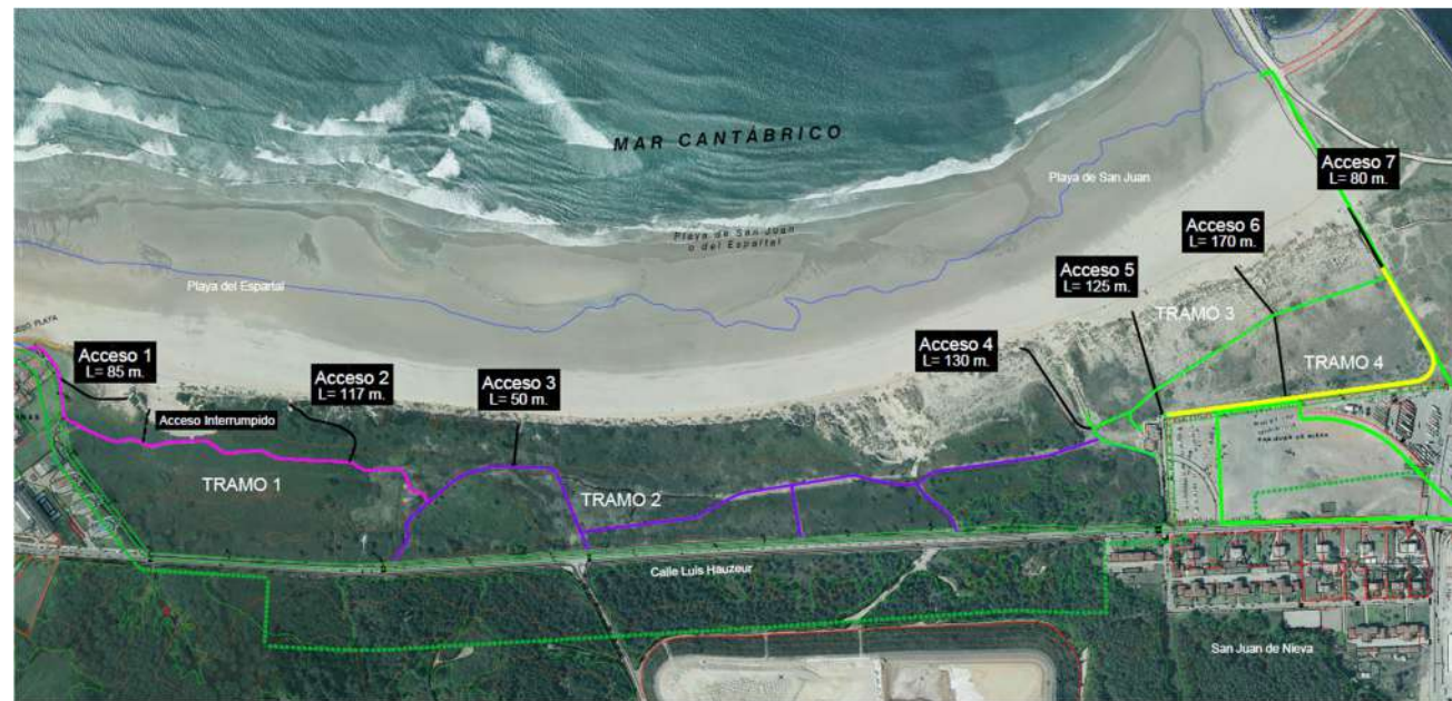
Figura 14 Tramos de pasarelas y de accesos a la playa a sustituir
