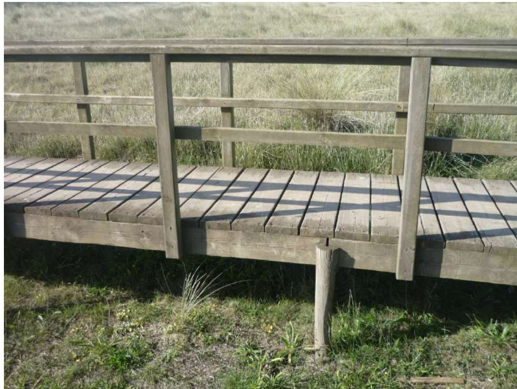
Figura 13 Detalle de la pasarela existente
