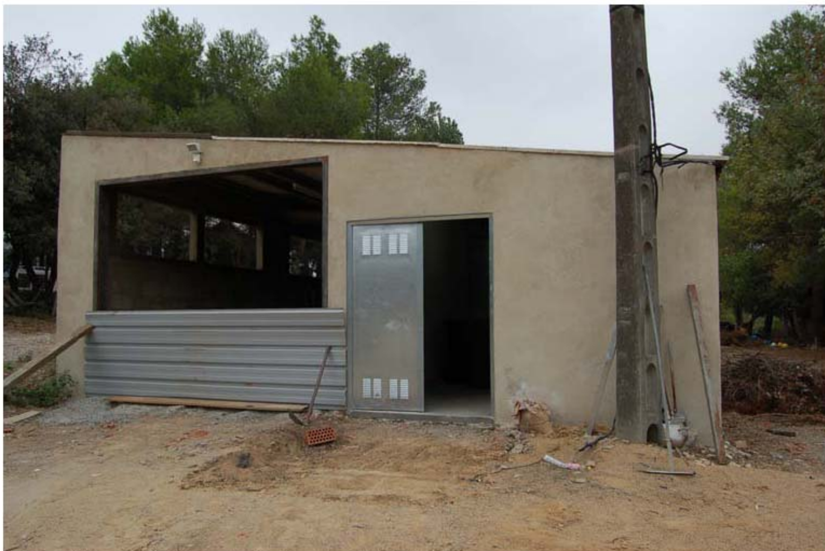
Fase d'obres a la Planta de Compostatge (6/9/2006)
