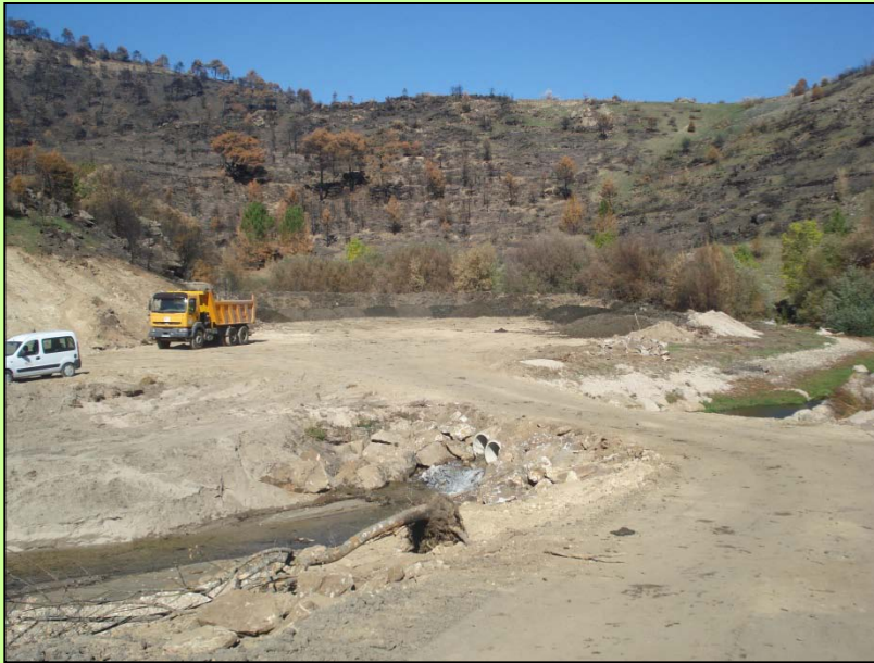
Ejecución de los trabajos
