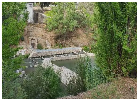
Fotografía 29. Recuperación de la continuidad longitudinal del río Manzanares en el entorno de El Pardo. Aspecto del azud antes y después de las obras de permeabilización.
