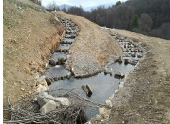
Fotografía 3. Sistema de paso para peces en el río Híjar (izq.) y en la presa de Santa Lucía (dcha.)
