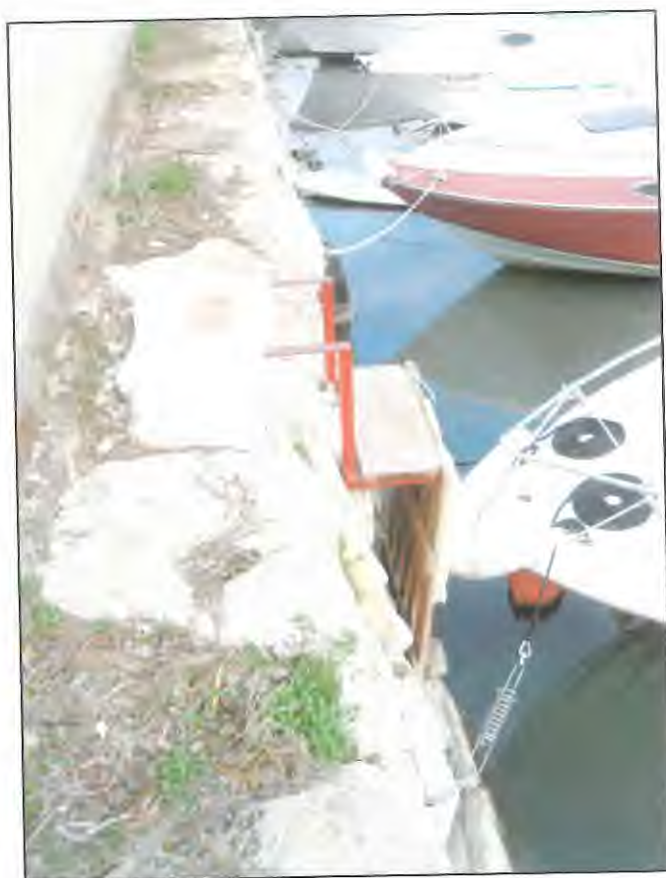
Fotografía 7: Plataforma metálica tomada con mortero.
