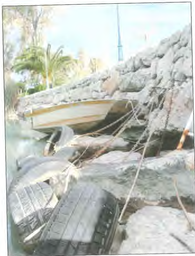
Fotografía 2: Tramos de cadenas para la sujeción de neumáticos de defensa.
