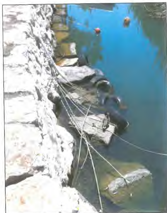
Fotografía nº15. Los años de uso incontrolado de amarre han provocado en algunos puntos absurdas acumulaciones de cadenas, cabos, neumáticos y otros elementos convirtiéndose en focos de contaminación.
