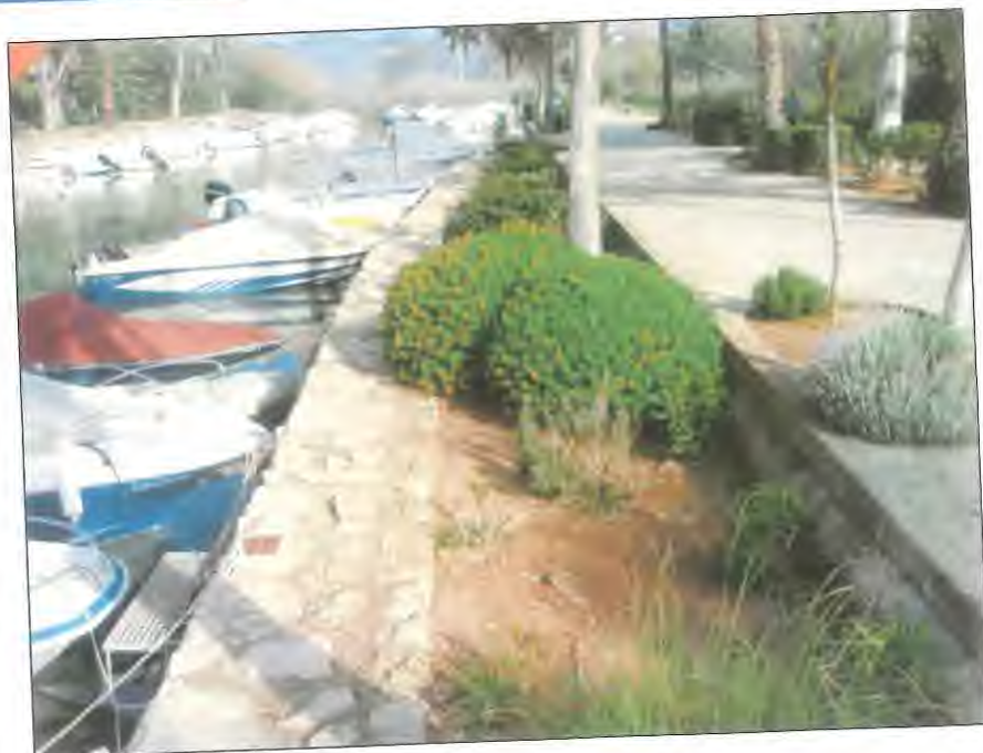
Fotografía nº10. Vista del cantil en el margen izquierdo del cauce. No existe continuidad entre el paseo y el acceso a las embarcaciones puesto que el paseo no ha sido concebido como muelle de amarre.
