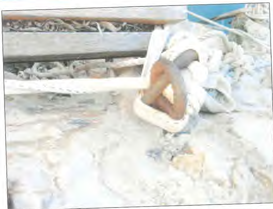
Fotografía 1: Elemento de amarre formado por una anilla y barra corrugada tomada con mortero
