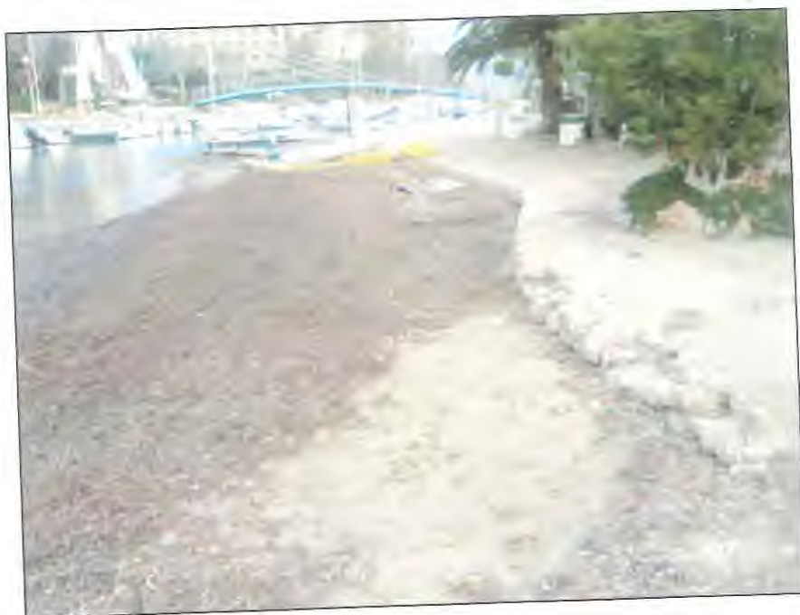
Fotografía nº4. Acumulación de sedimentos en el margen izquierdo de la desembocadura, se observa el muro de piedra que delimita el paseo en la ribera del río.
