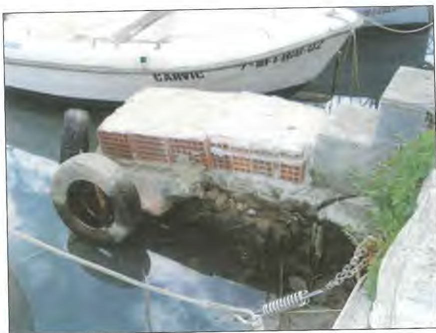
Fotografía nº17. Vista de una estructura de acceso realizada con bloques de hormigón, ladrillo y mortero sin ningún tipo de homogeneidad con respecto al cantil y realizada de manera rudimentaria.
