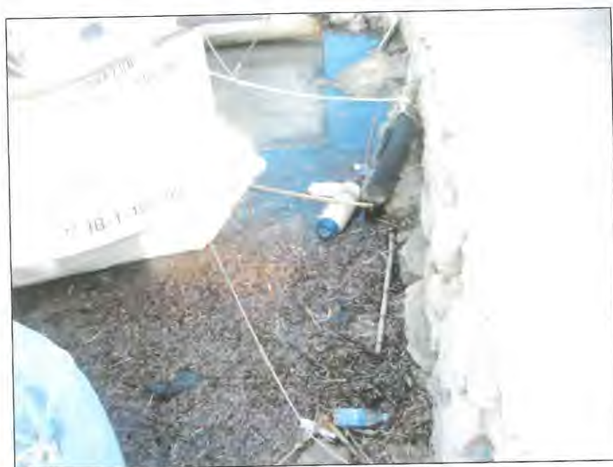
Fotografía nº9. Vista del muro del margen del cauce, se observan los elementos de amarre en mal estado, neumáticos, defensas y la suciedad debida a algas muertas y a desechos de las embarcaciones.
