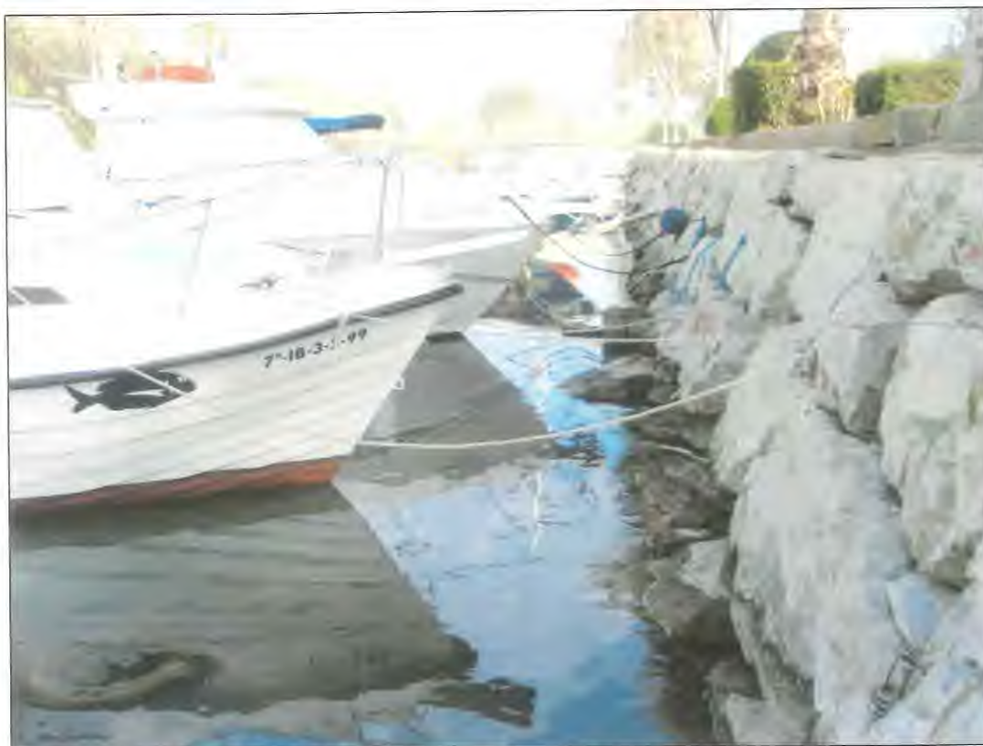
Fotografía nº9: Muro de escollera mampuesta prácticamente vertical.
