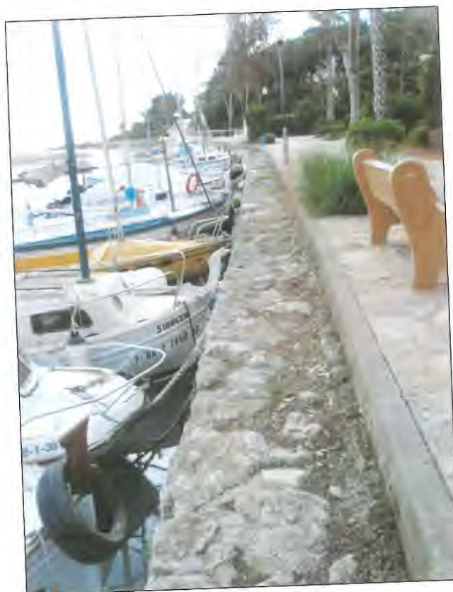
Fotografía nº11. Vista del cantil del margen derecho, tanto la superficie como el bordillo no facilitan el acceso a las embarcaciones.
