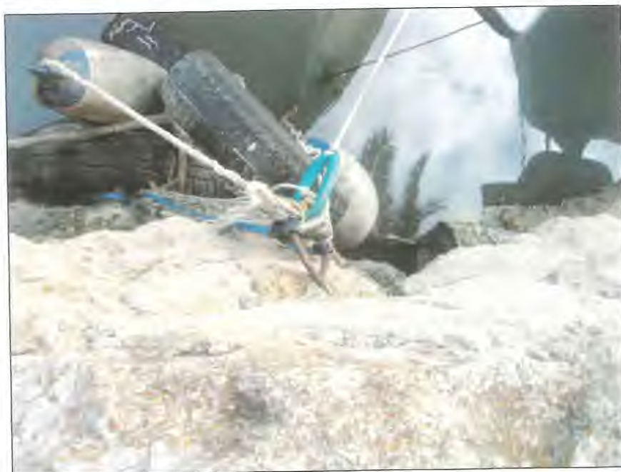
Fotografía nº14. Vista del cantil. El elemento de amarre consistente en una barra corrugada tomada con mortero. Amarrados a la misma se encuentran guías, amarras, neumáticos, defensas, etc. La constitución de los anclajes y su estado de conservación no ofrecen garantía de seguridad al amarre.
