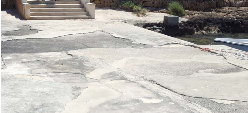
Foto 6: Vista detalle de estado actual del pavimento del embarcadero.
