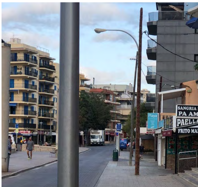
Báculos con luminaria asimétrica cerrada con lámpara de descarga.
