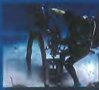
Verificación de la correcta instalación de la barra de impulso MANTA RAY® El diversista debe asegurarse de que la barra de impulso esté correctamente instalada y fijada a la estructura de la instalación.
