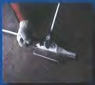
Instalación de la barra de impulso MANTA RAY® El diversista debe asegurarse de que la barra de impulso esté correctamente instalada y fijada a la estructura de la instalación.
