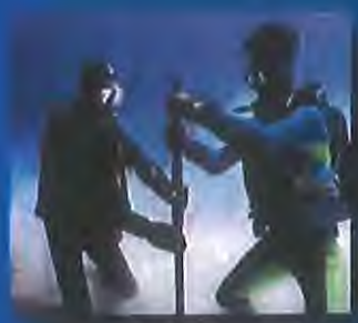
Verificación de la correcta instalación de la barra de impulso MANTA RAY® El diversista debe asegurarse de que la barra de impulso esté correctamente instalada y fijada a la estructura de la instalación.
