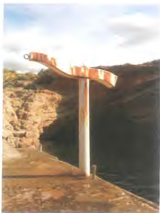
Fotografía 4.- Vista de la grúa.
