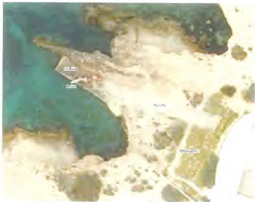
Fotografía 2.- Vista aérea. Rampa de varada, muelle, grúa y escalera.
