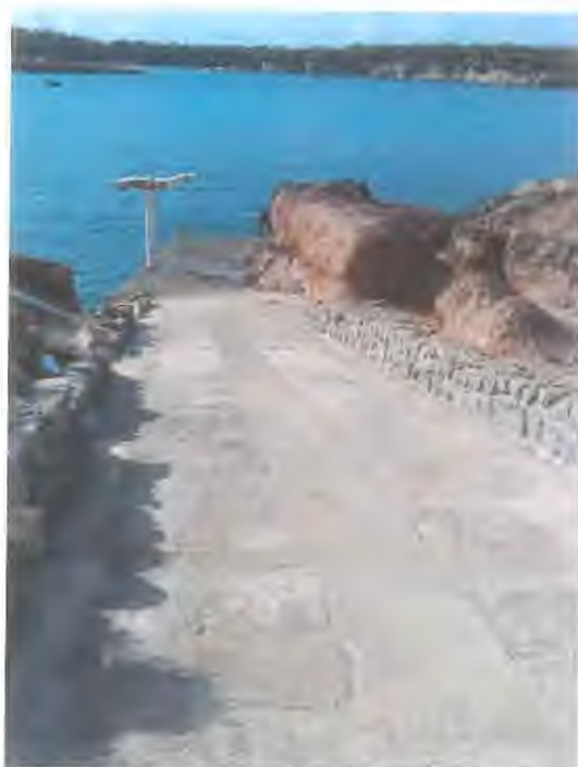
Fotografía 3.- Vista de la rampa, muelle y grúa hacia el mar desde la vivienda.
