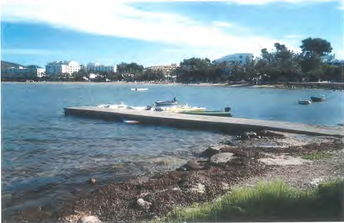
Fotografía 5.- Vista general del embarcadero desde tierra.
