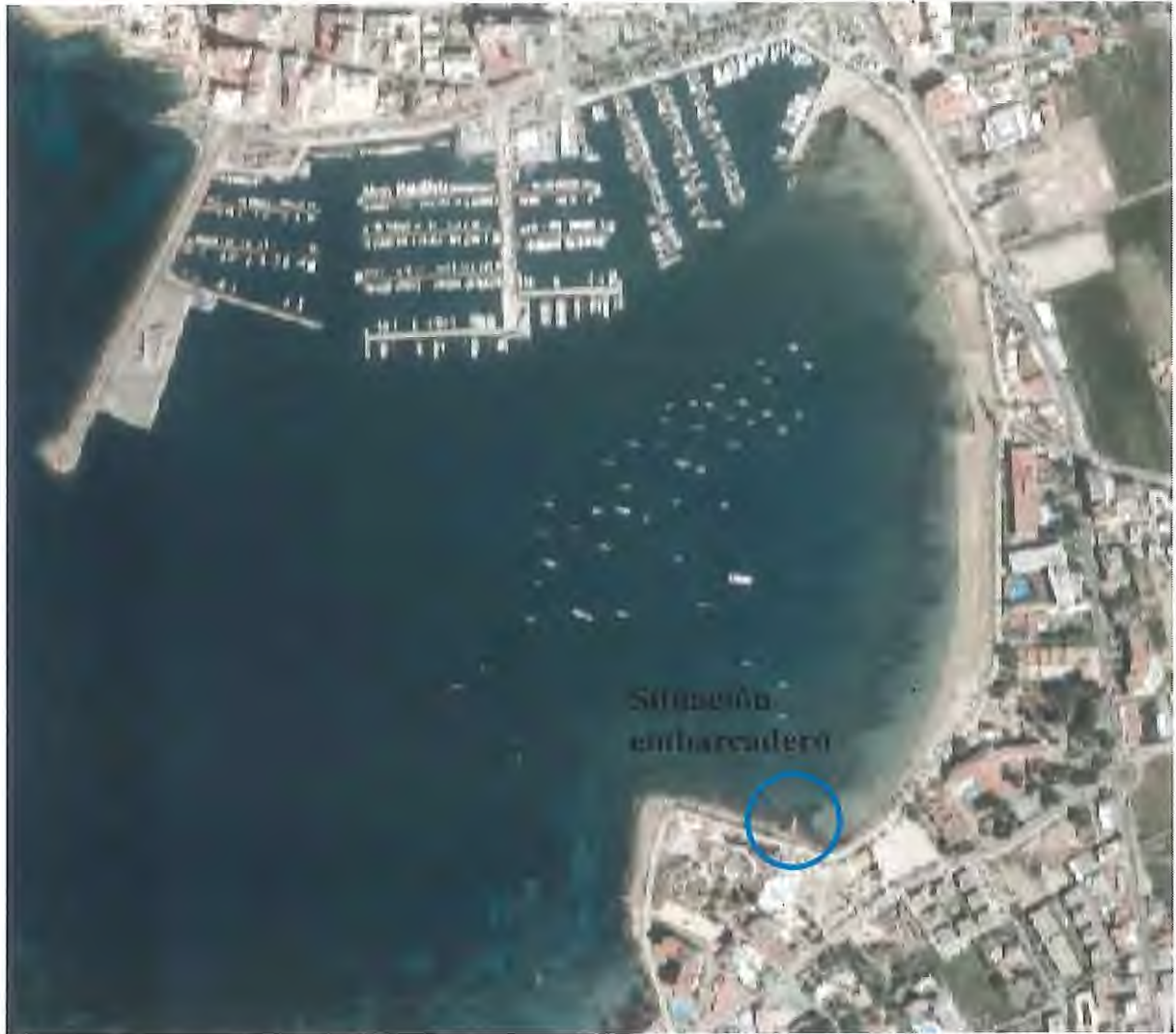
Fotografía 1.- Imagen aérea del año 2012 de la Bahía de Sant. Antoni. Ubicación del embarcadero objeto del proyecto.
