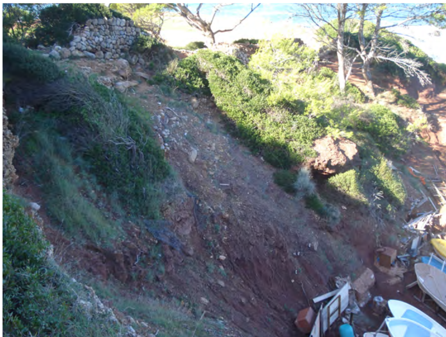
Foto 4: Talud arcilloso donde se ejecutarán bancales para incrementar su estabilidad.
