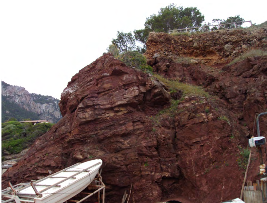
Foto 8: Bloques potencialmente inestables en el talud sureste.
