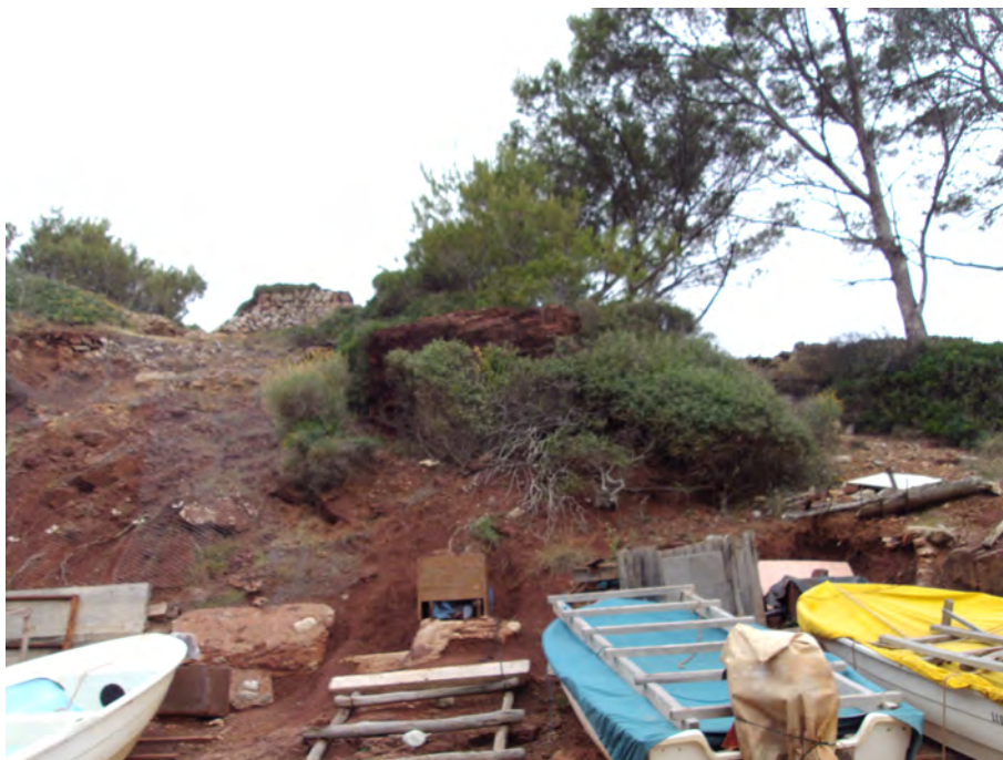
Foto 7: Bloque inestable a sanear en el talud noroeste.
