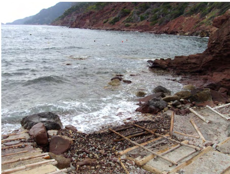
Foto 9: Imagen del borde litoral en el varadero: defensa del oleaje deficiente.
