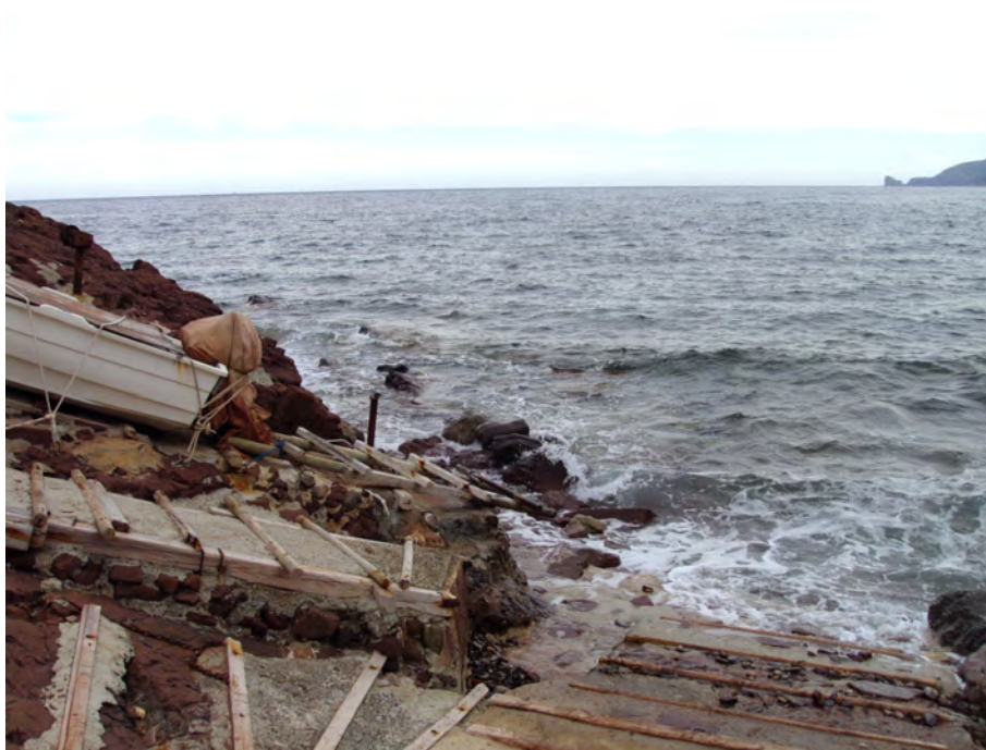
Foto 10: Escollera a recolocar para mejorar la defensa del varadero frente al oleaje.
