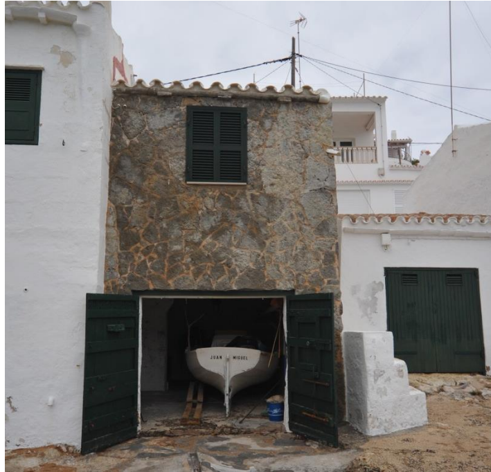
Figura 3. Fachada sur, puerta de madera con herrajes y pintura de verde carruaje.
