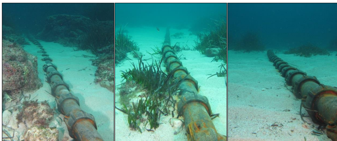
Ilustración 65. Detalle de ruta del cable con protecciones metálicas en tramo somero (REE, 2016).
