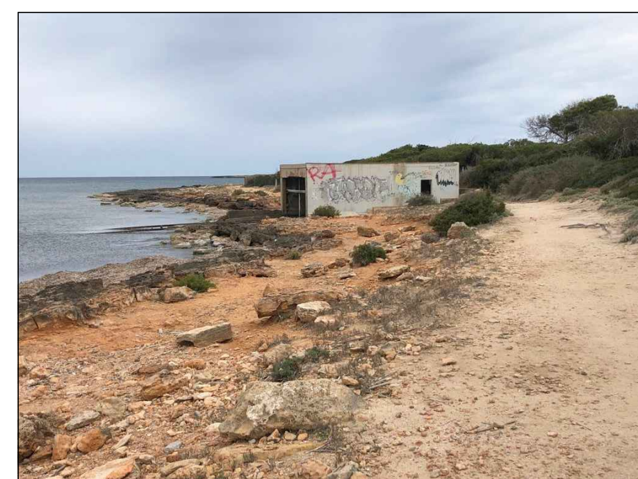
FOTO 2. FACHADA LATERAL DERECHA
