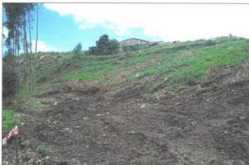
Fotografía 3: zona donde se ubica el estribo E-1.
