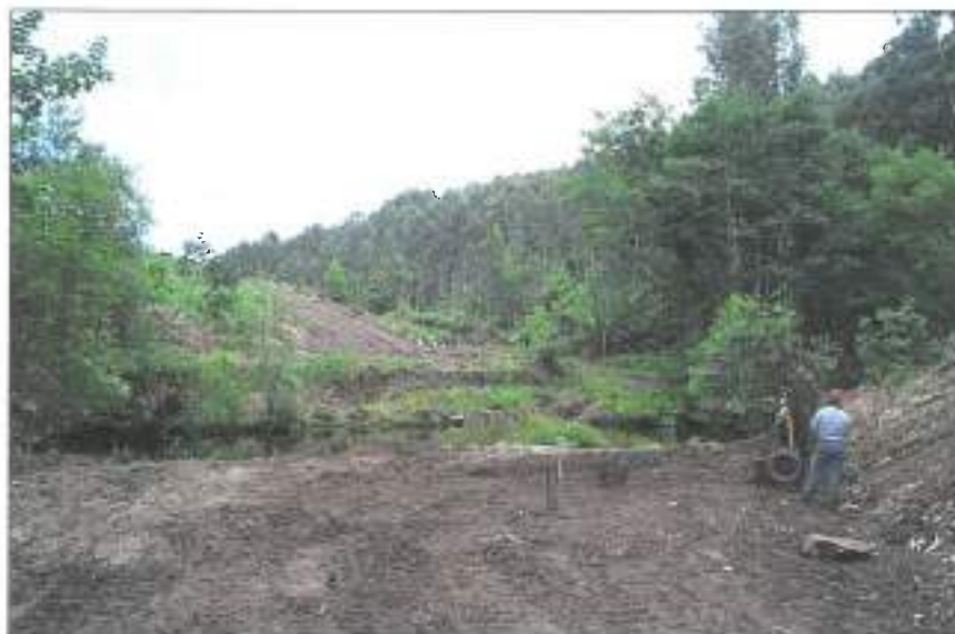
Fotografía 5: en primer término ubicación del estribo E-2.
