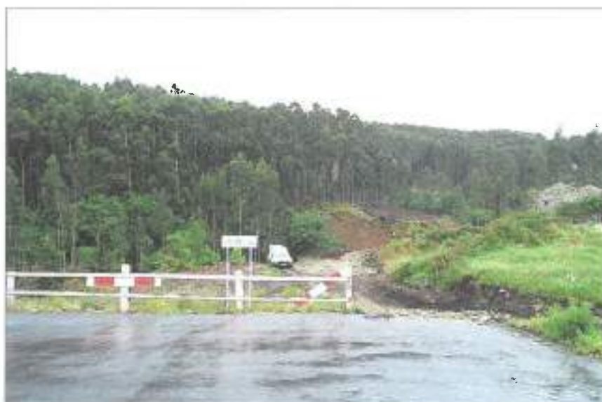
Fotografía 1: vista general de la zona de enlace con el tramo procedente de Burela.
