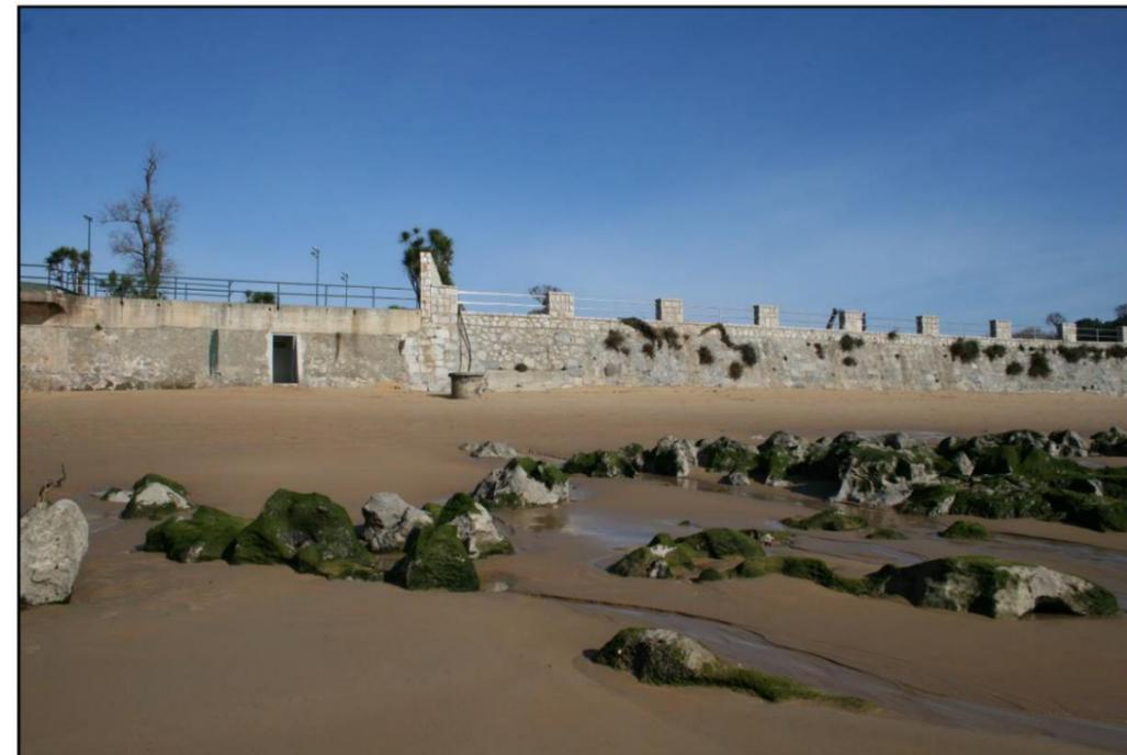
*Imagen 7. Muro de contención de los rellenos que se realizaron a principios del Siglo XX para la construcción del Campo de Polo, fotografiados desde la playa de La Magdalena. Fuente: Proyecto de Estabilización del Sistema de Playas Magdalena-Peligros, T.M. Santander.*
