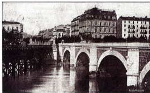
Puente de Santa Catalina junto al puente de madera antes de ser demolido.
