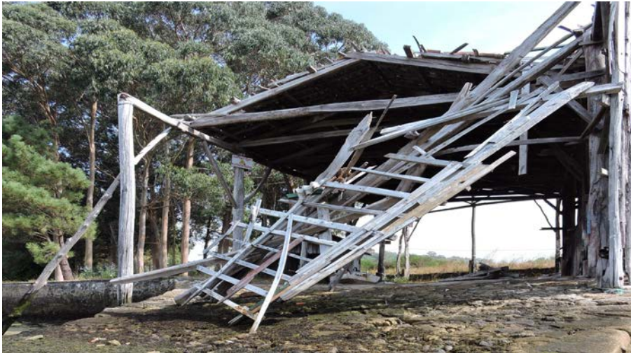
IMAGEN 2.5 DETALLE DEL ESTADO RUINOSO DEL VOLADIZO SOBRE LA RAMPA.
