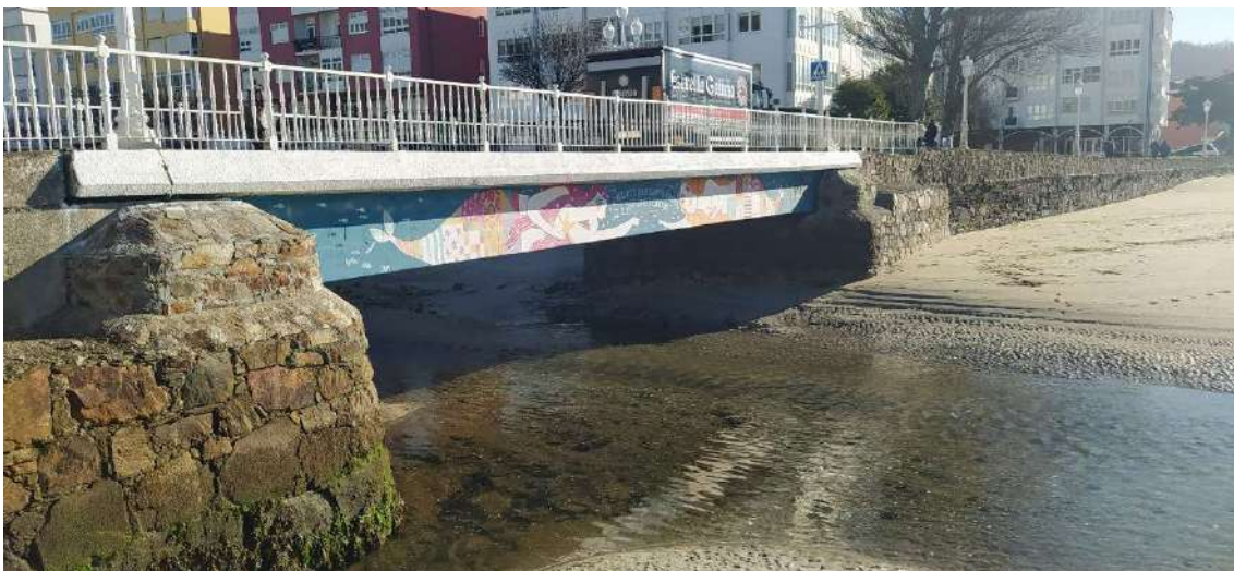
Vista desde aguas abajo
