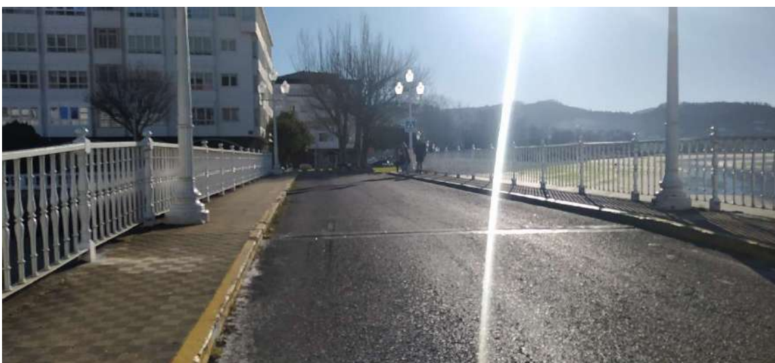
Plataforma del puente y aceras a renovar
