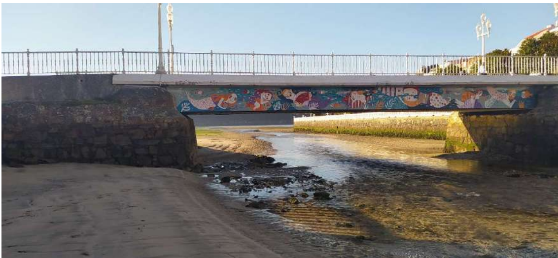
A Ponte Nova vista desde aguas arriba
