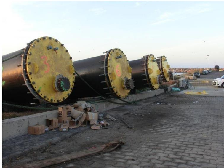
Figura 28. Bridas ciega de cierre para llenado y hundimiento de la conducción
