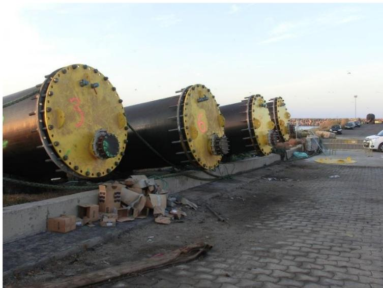
Figura 10. Bridas ciegas de cierre para llenado y hundimiento de la conducción
