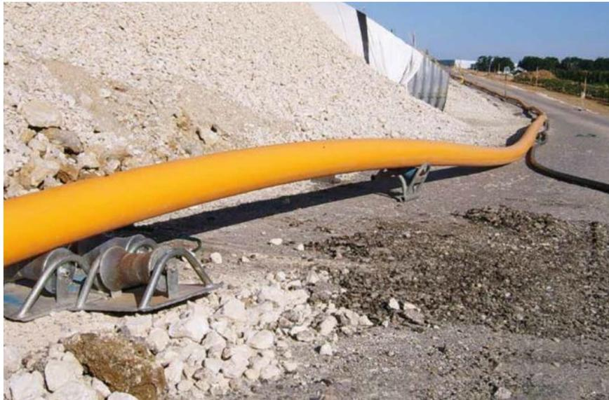
Figura 9. Elementos tipo roderas para evitar el rozamiento de la conducción
