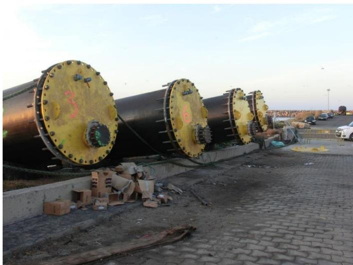
Figura 56. Bridas ciega de cierre para llenado y hundimiento de la conducción
