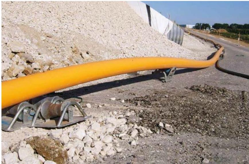
Figura 36. Elementos tipo roderas para evitar el rozamiento de la conducción
