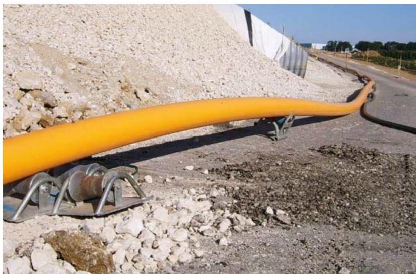
Figura 66. Elementos tipo roderas para evitar el rozamiento de la conducción
