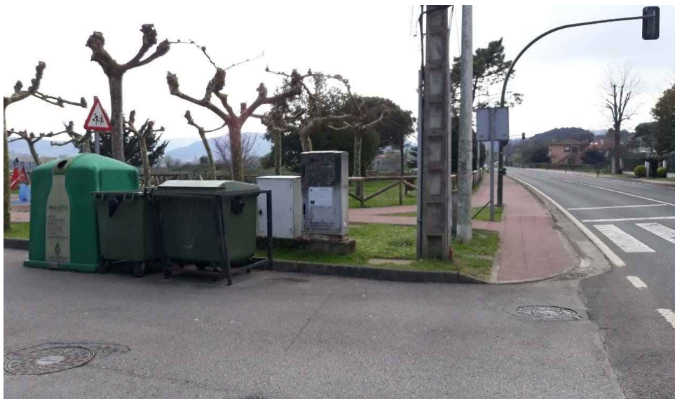
Foto 1: Apoyo de hormigón P2 dentro de la zona de Dominio Público Marítimo-Terrestre.
