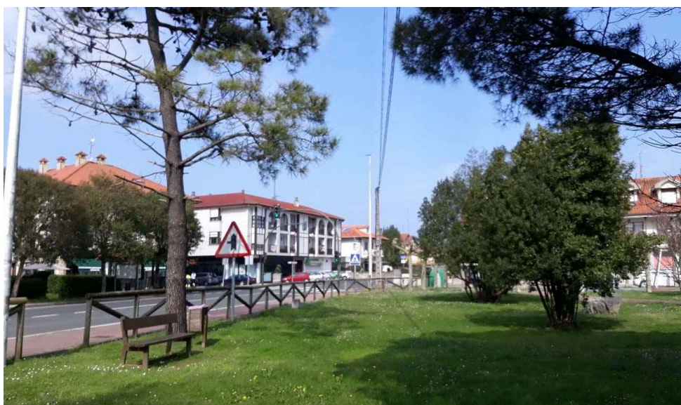
Foto 2: Vuelo de línea de baja tensión dentro de la zona de Dominio Público Marítimo-Terrestre.
