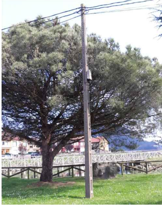
Foto 3: Apoyo de hormigón P3 dentro de la zona de Dominio Público Marítimo-Terrestre.
