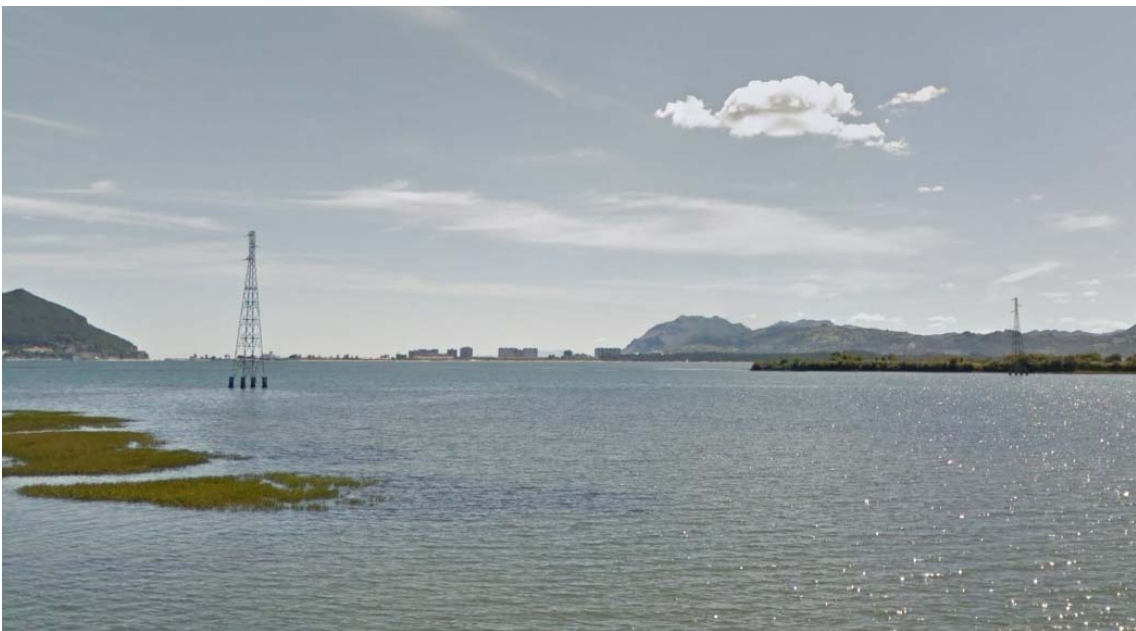
Foto 2: Desmontaje de línea aérea en DPMT.
