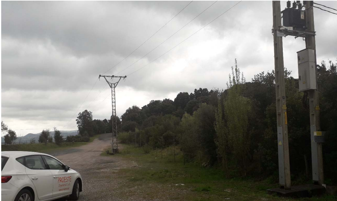
Foto 3: Desmontaje de línea aérea y CTI en DPMT.
