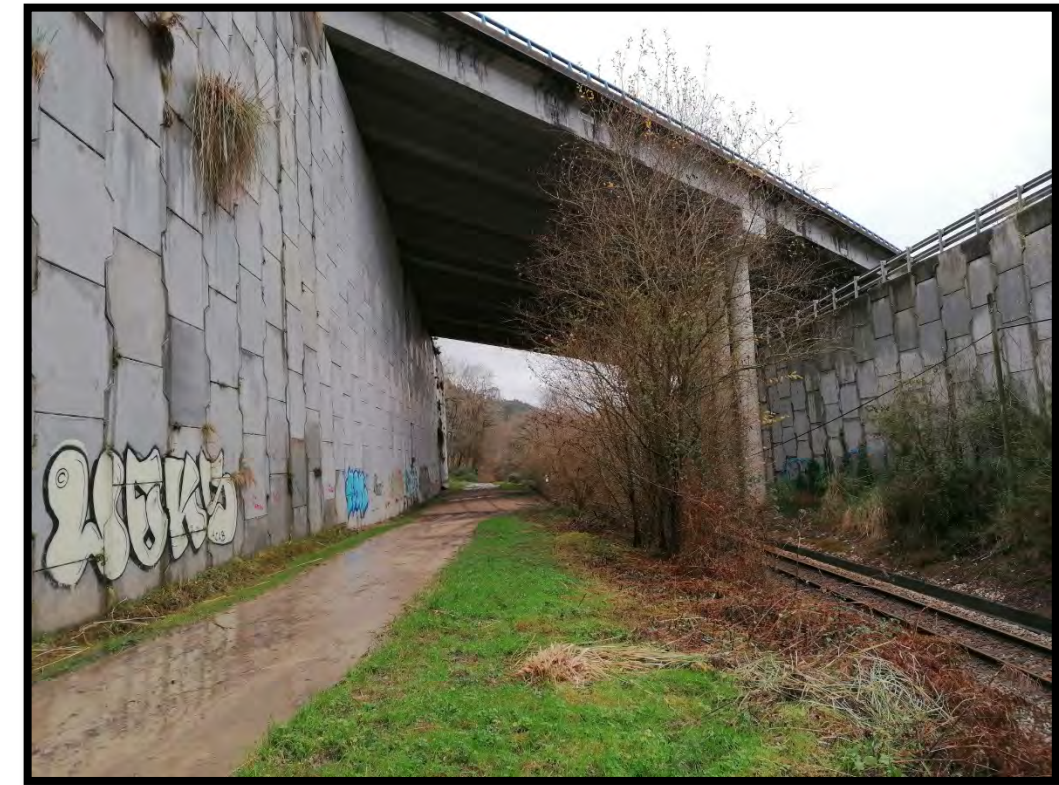
Fotografía nº8.- Paso bajo la autovía A8.
