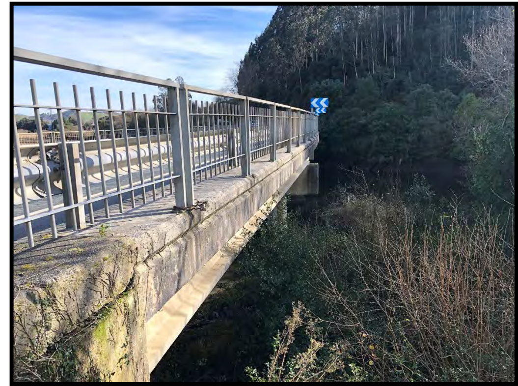
Fotografía nº10.- Viaducto existente sobre el río Nansa
