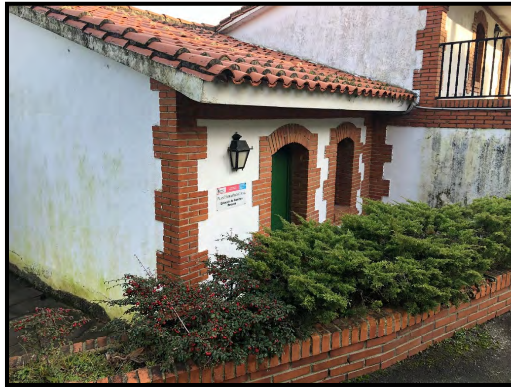
Fotografía nº9.- Edificio bombeo Pesués
