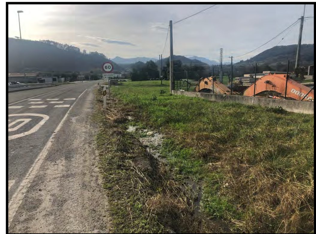
Fotografía nº11.- Fin del tramo de acera a ejecutar en la margen derecha de la N-634
