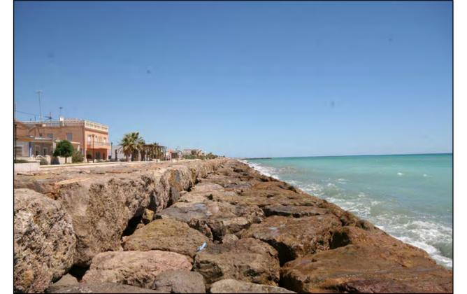
Escollera de protección a demoler parcialmente para su posterior uso en la construcción de los espigones, a criterio de la D.O.
