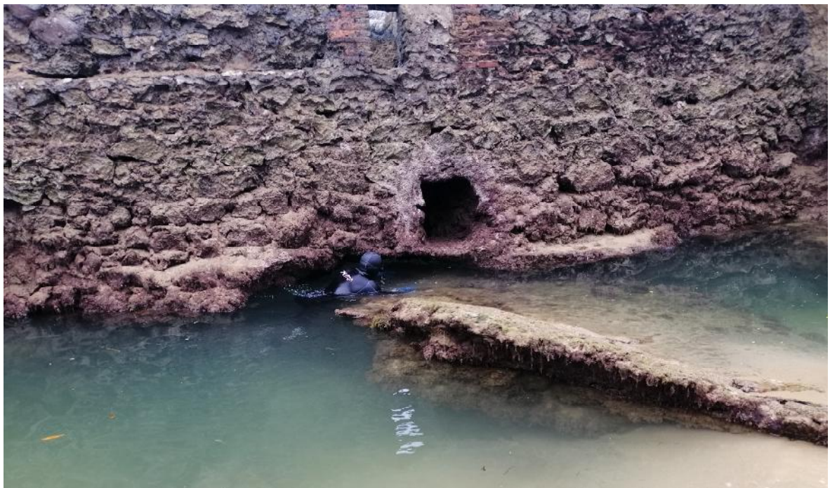
Vista interior del muro de la piscina
