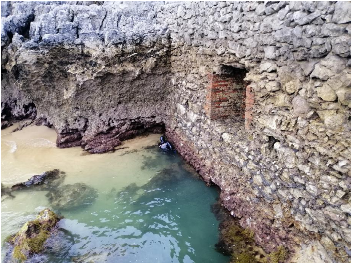
Vista exterior del muro
