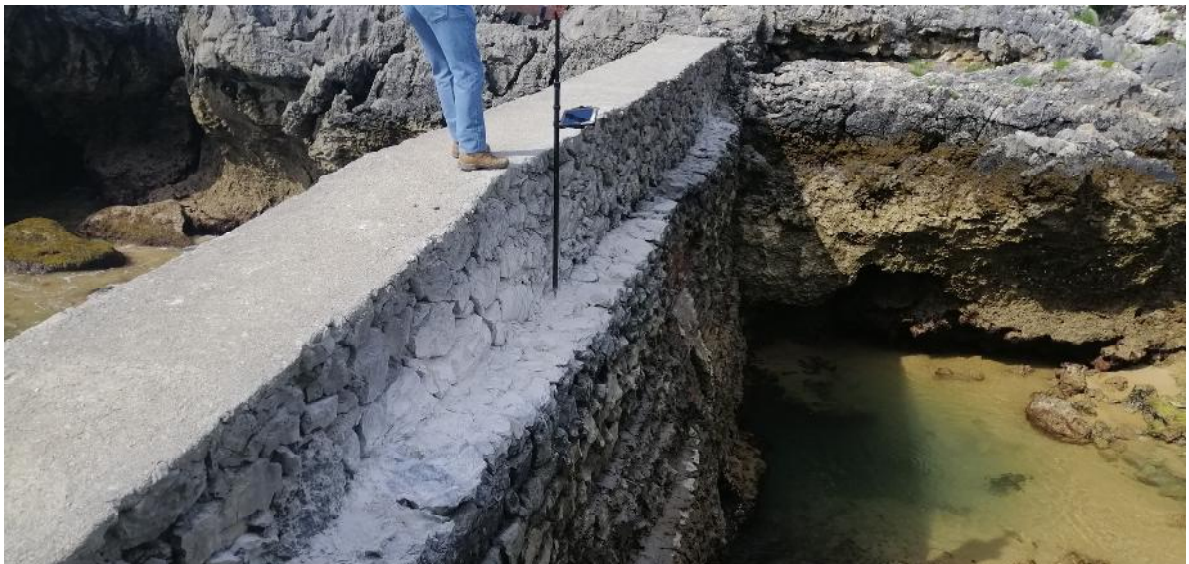
Vista zona superior muro
