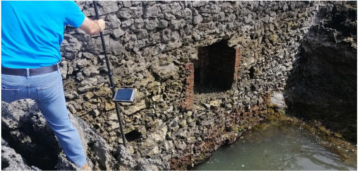
Vista ventana superior de desagüe
